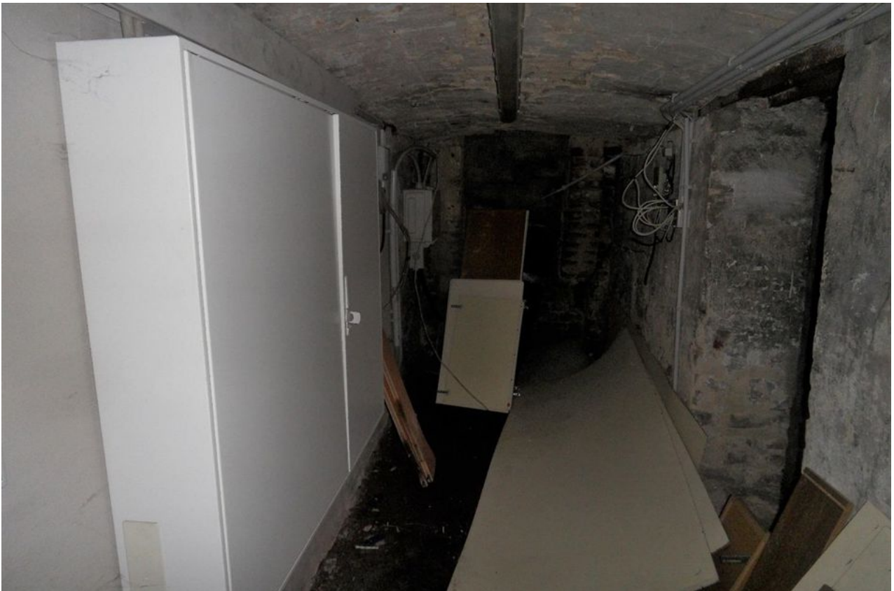
Kellerflur (Foto des Sachverständigen anlässlich eines Ortstermins im gleichen Gebäude am 23.11.2016).
