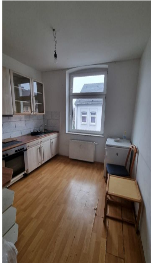
WE 4.2; Küche mit schadhaftem Oberbodenbelag.
