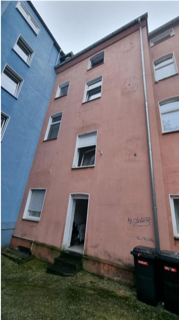
Gebäuderückseite mit Blick auf die Nebeneingangstür zum Treppenhaus.
