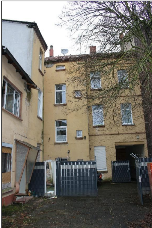
Foto Nr. 3: Hoffassade
