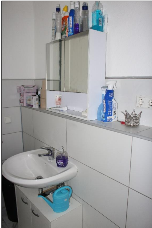
Foto Nr. 19: 1. OG mittig, ETW Nr. 5, Bad
