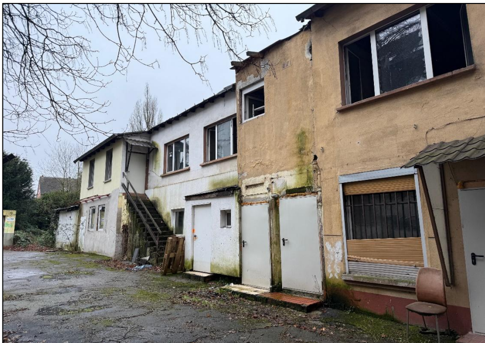
Foto Nr. 8: Nebengebäude
