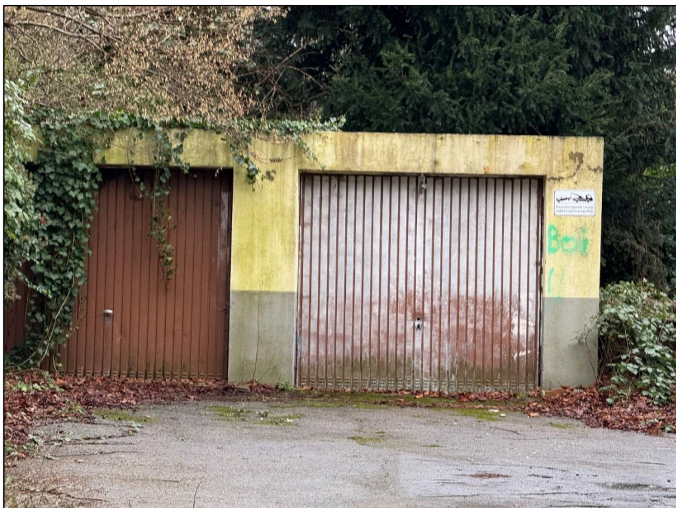
Foto Nr. 12: Garagen
