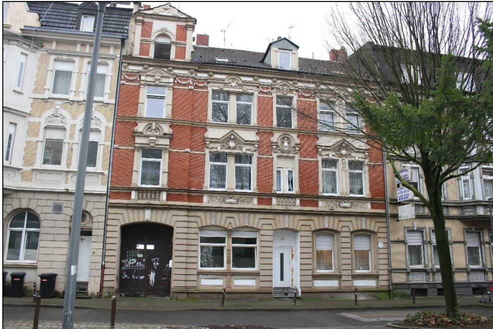
Foto Nr. 1: Straßenfassade
