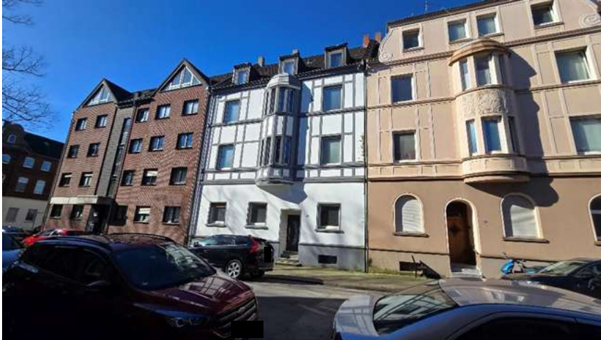
Straßenseitiger Blick auf das Mehrfamilienhaus.
