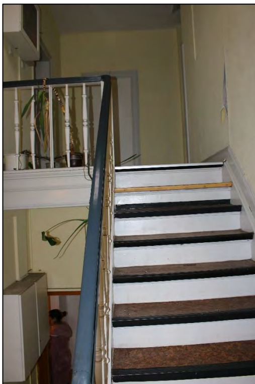
Foto Nr. 64: Gemeinschaftstreppehaus, Dachgeschoss
