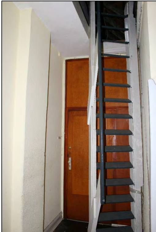
Foto Nr. 67: Gemeinschaftstreppe, Dachgeschoss, Eingang WE Nr. 6
