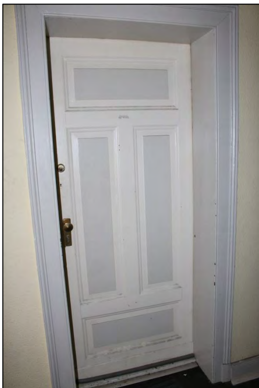
Foto Nr. 68: Gemeinschaftstreppe, Dachgeschoss, Eingang WE Nr. 7
