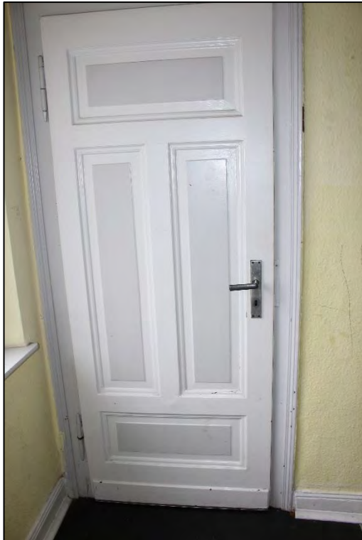
Foto Nr. 51: Gemeinschaftstreppehaus, Abstellraum, Treppenpodest
