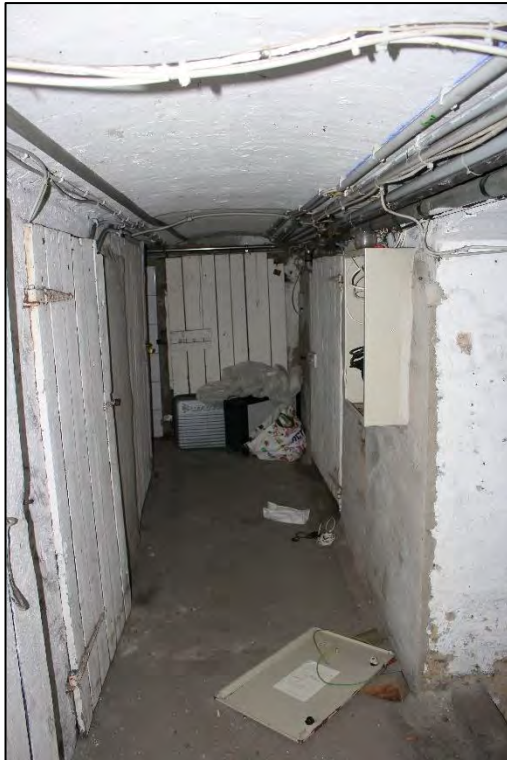
Foto Nr. 23: Kellergeschoss, Flur
