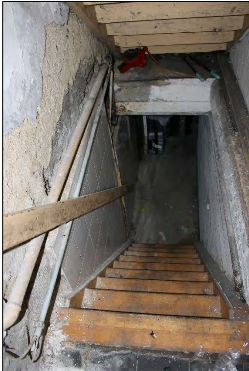
Foto Nr. 17: Treppe zum Kellergeschoss
