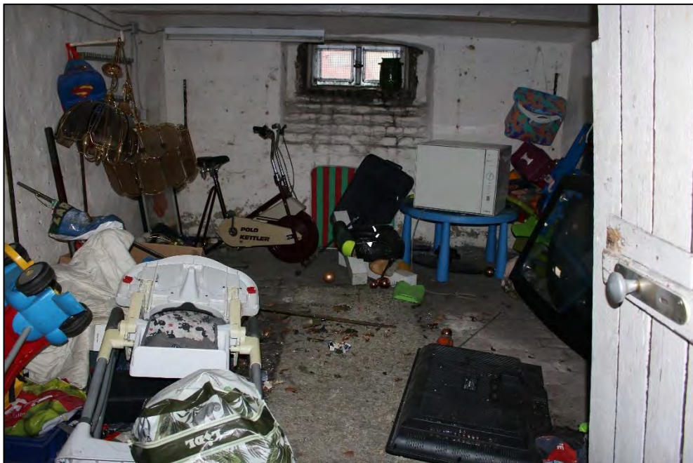
Foto Nr. 20: Kellergeschoss, Kellerraum
