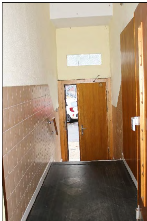
Foto Nr. 14: Gemeinschaftstreppe, Erdgeschoss, Hauseingang
