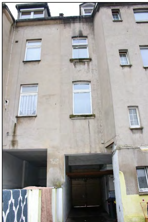
Foto Nr. 8: Hoffassade
