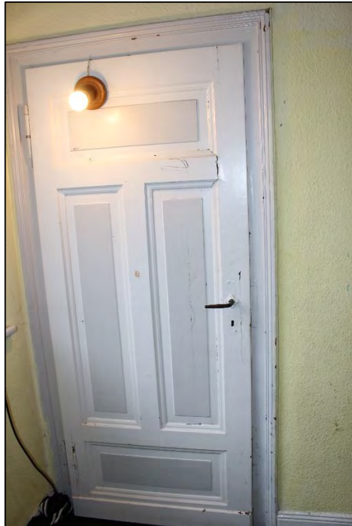
Foto Nr. 37: Gemeinschaftstreppehaus, Abstellraum, Treppenpodest
