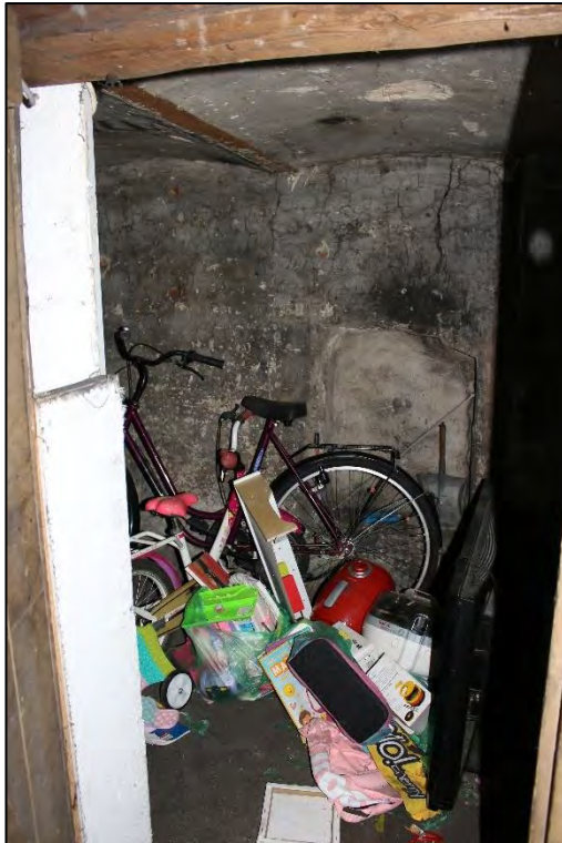
Foto Nr. 25: Kellergeschoss, Kellerraum
