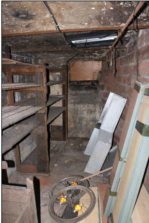
Foto Nr. 21: Kellergeschoss, Kellerraum
