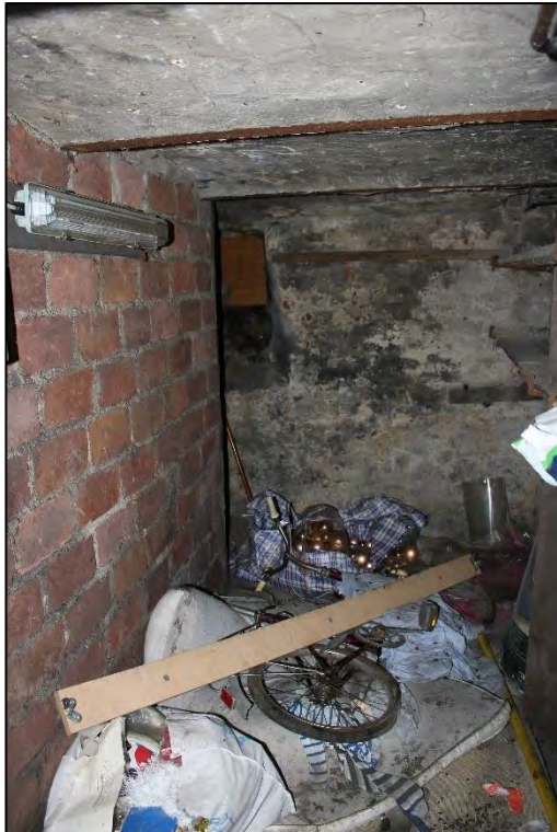
Foto Nr. 19: Kellergeschoss, Kellerraum
