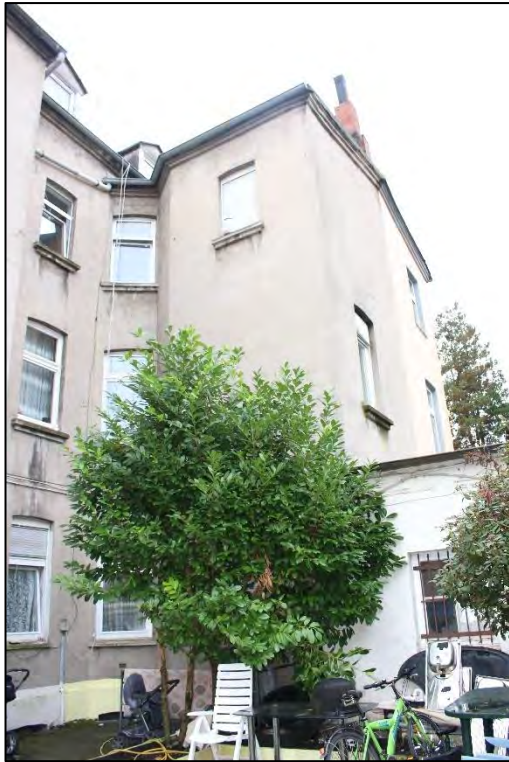
Foto Nr. 9: Hoffassade
