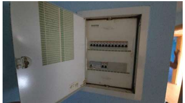
WE 7, DG; Elektrounerverteilung in der WE.
