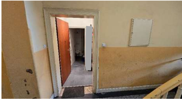
Treppenhaus, EG; Wohnungstür zu WE 2.
