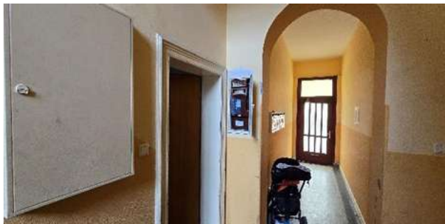
Treppenhaus im EG mit Blick in den Hausflur.
