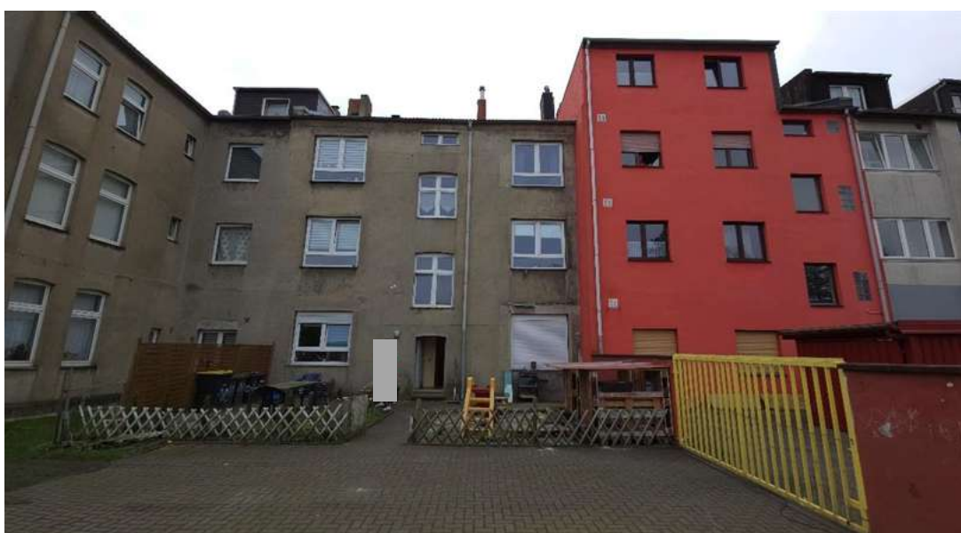
Gebäuderückseite mit Nebeneingangstür und Tor zum Nachbargrundstück.
