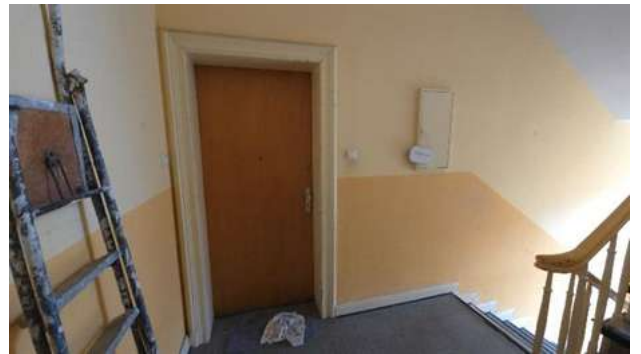
Treppenhaus, Wohnungsabschlusstür zu WE 4.
