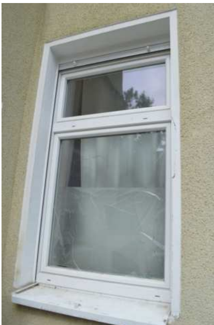
Bild 17: defekte Fensterscheibe
