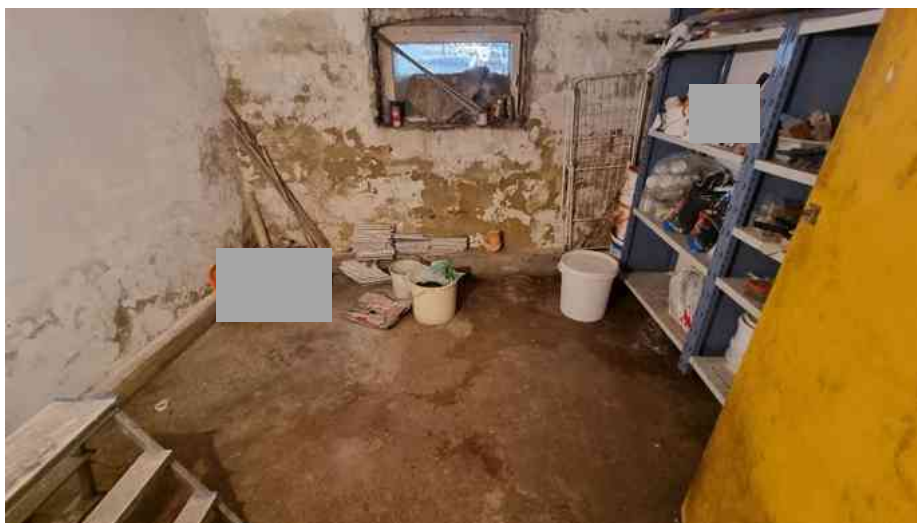
KG; Kellerraum zu WE 6 mit Feuchtigkeitsschäden an den Wandinnenflächen.
