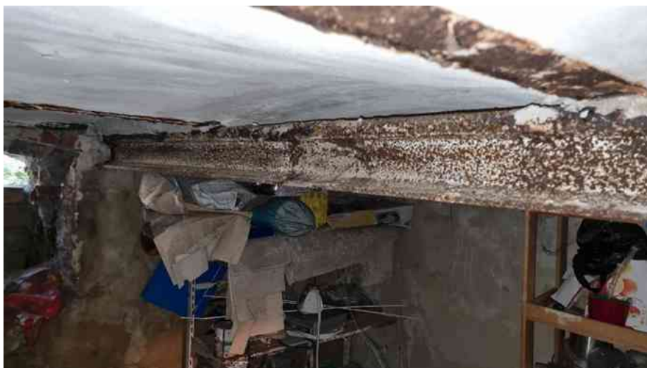
KG; Kappendecke mit schadhaften Eisenträgern.
