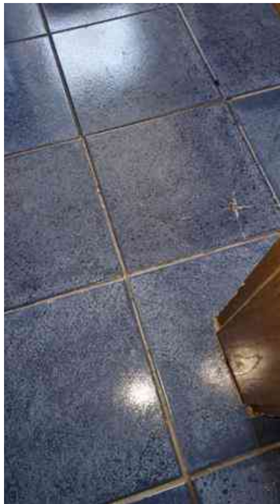
OG WE 3; Risse im keramischen Bodenbelag.
