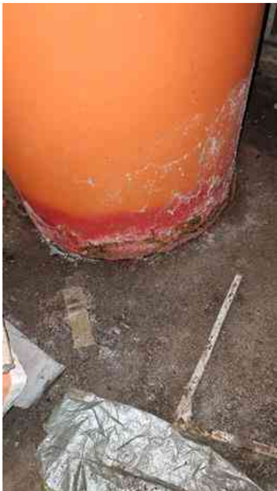
KG; Warmwasserspeicher mit starkem Rostschaden.
