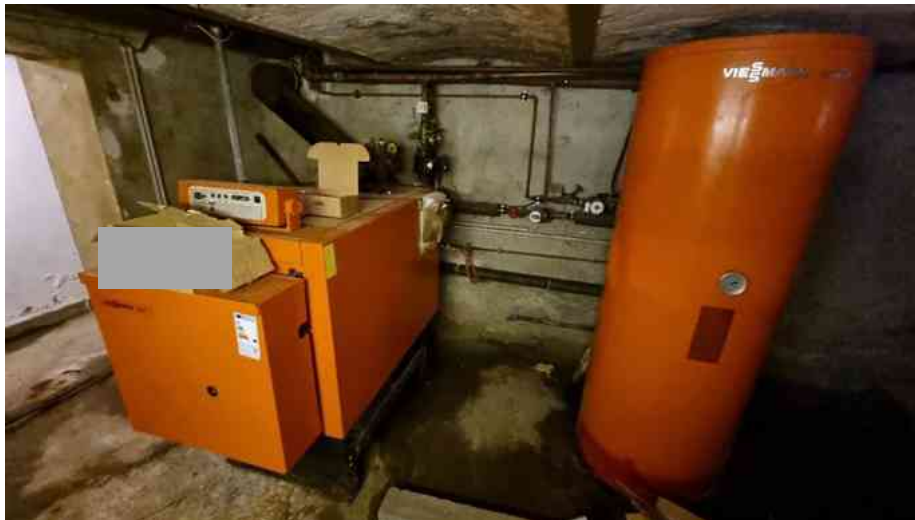
KG; Zentrale Heizungsanlage.
