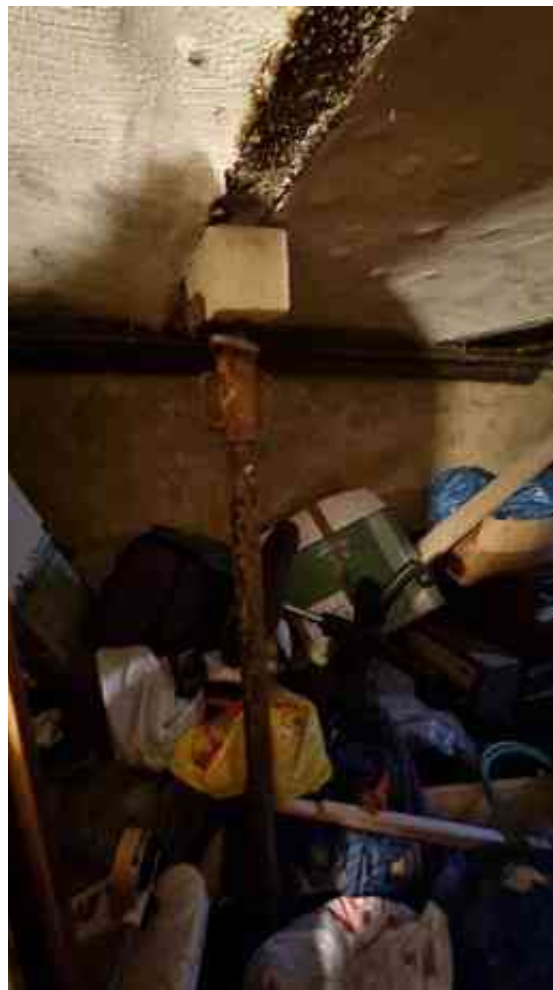
KG; Laienhaft installierte Stütze unter einem Deckenträger.
