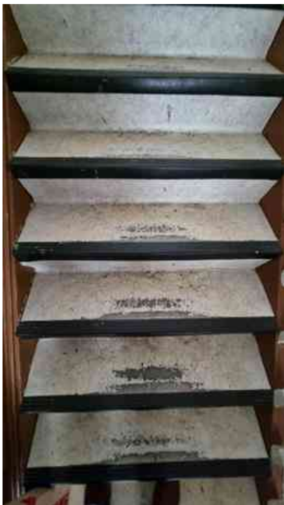
Treppenraum / Abnutzung der Treppenanlage.
