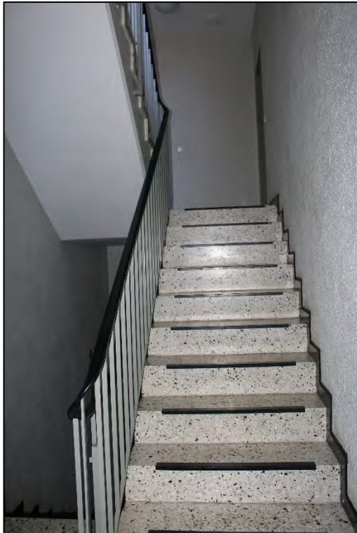
Foto Nr. 17: Gemeinschaftstreppe, Bochumer Straße 129
