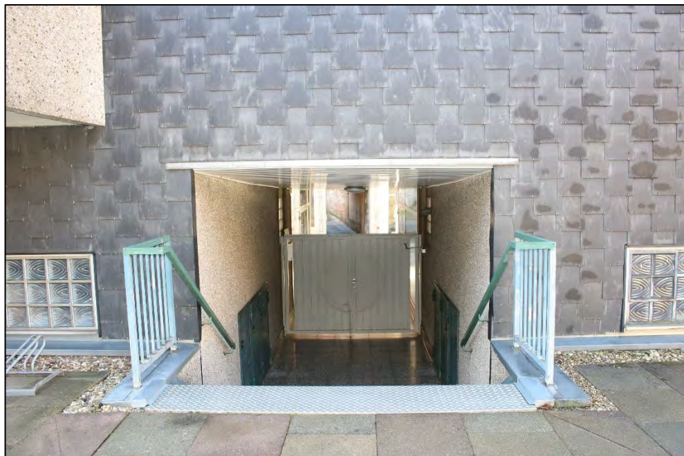
Foto Nr. 4: Zugang zum Hof
