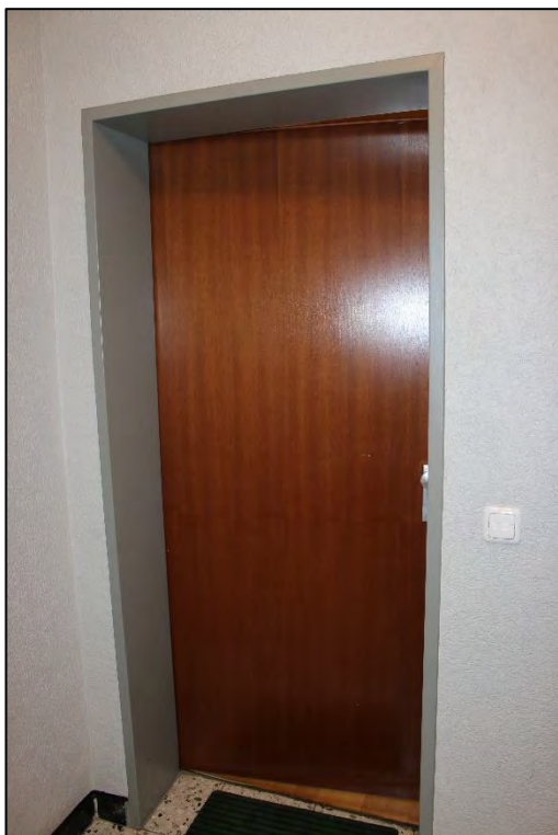
Foto Nr. 18: Gemeinschaftstreppe, Bochumer Straße 129, Eingang ETW Nr. 9
