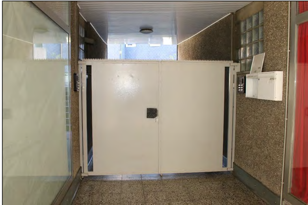
Foto Nr. 3: Zugang zum Hof
