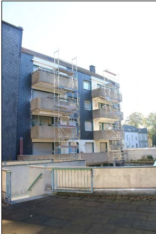
Foto Nr. 7: Hoffassade Heidelberger Straße 20
