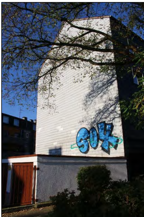
Foto Nr. 8: Seitenfassade Heidelberger Straße 20
