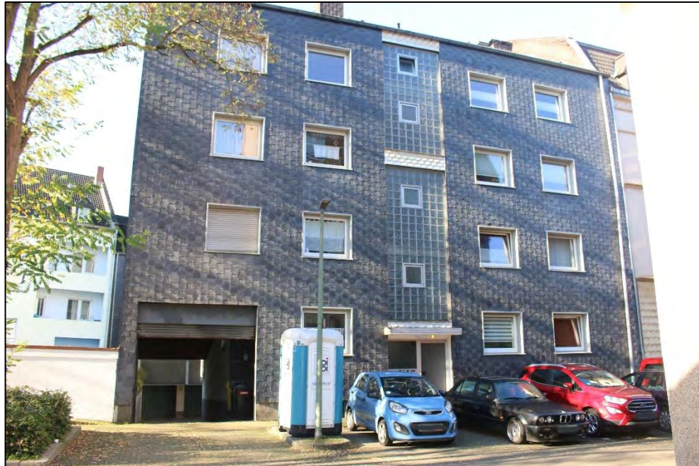
Foto Nr. 9: Straßenfassade Heidelberger Straße 20
