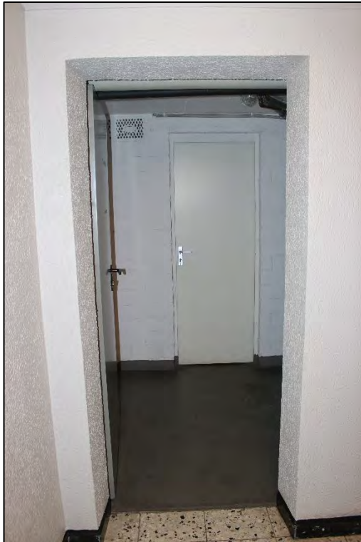
Foto Nr. 33: Bochumer Straße 129, Kellergeschoss, Flur
