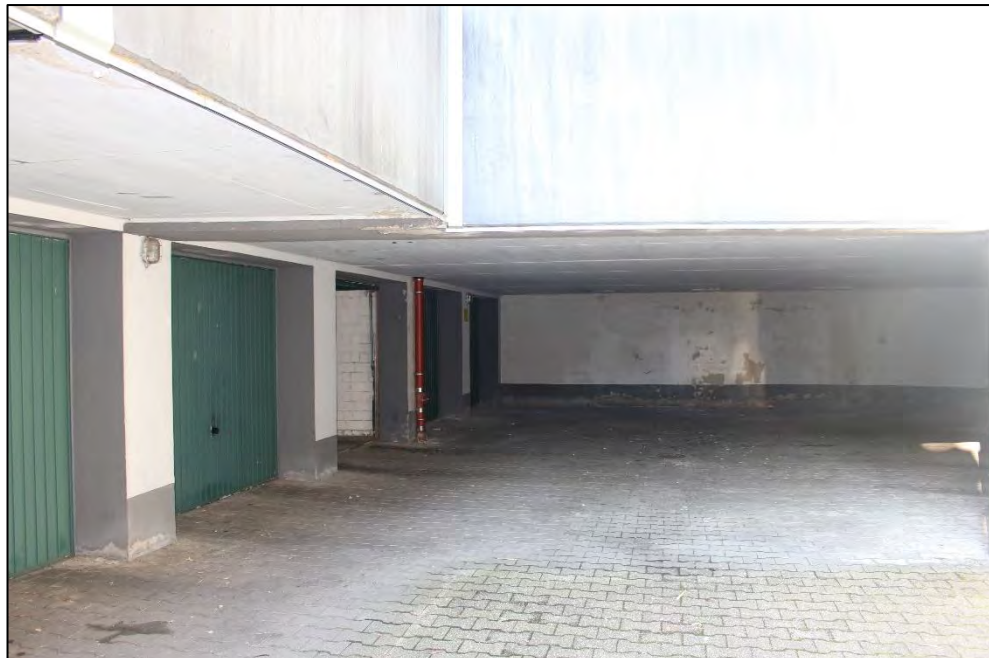
Foto Nr. 10: Garagenhof Bochumer Straße 129 / 131, Heidelberger Straße 20
