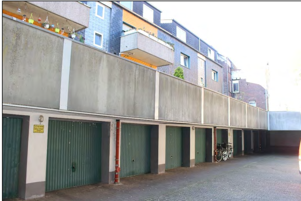
Foto Nr. 11: Garagenhof Bochumer Straße 129 / 131, Heidelberger Straße 20
