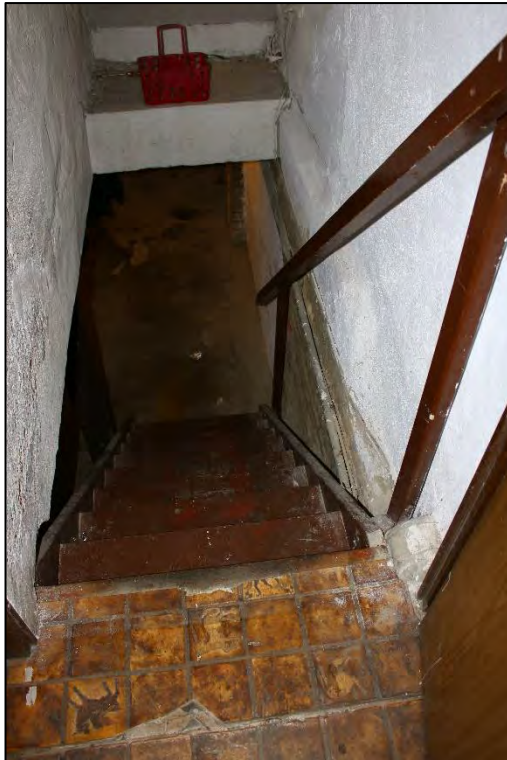
Foto Nr. 11: Treppe zum Kellergeschoss
