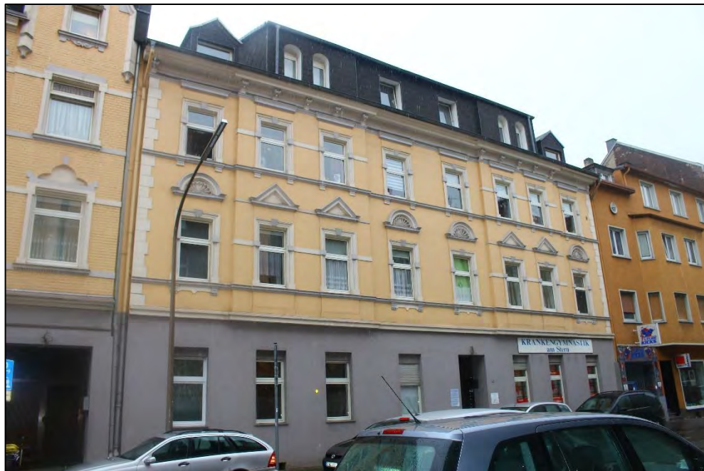
Foto Nr. 1: Straßenfassade
