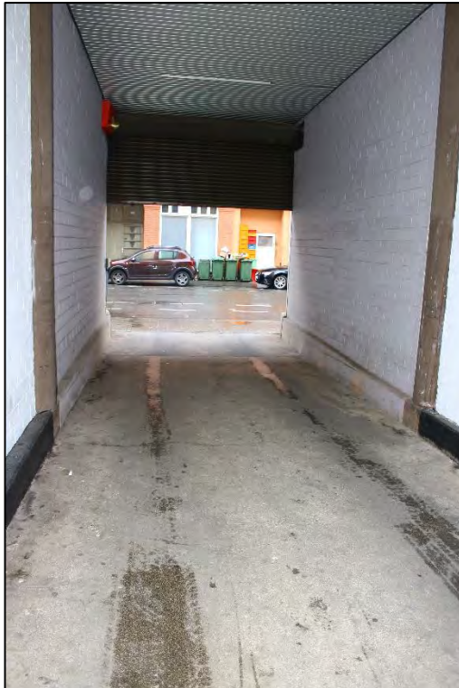
Foto Nr. 3: Durchfahrt
