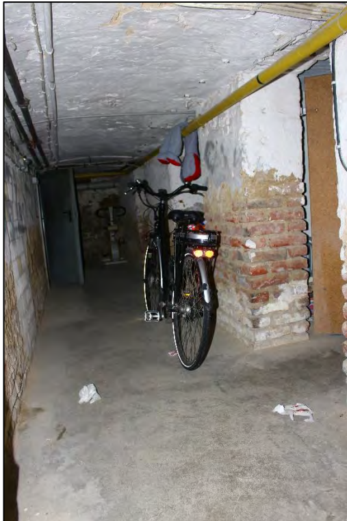
Foto Nr. 13: Kellergeschoss, Flur
