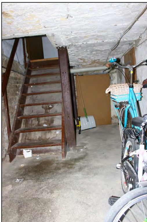
Foto Nr. 12: Kellergeschoss, Flur
