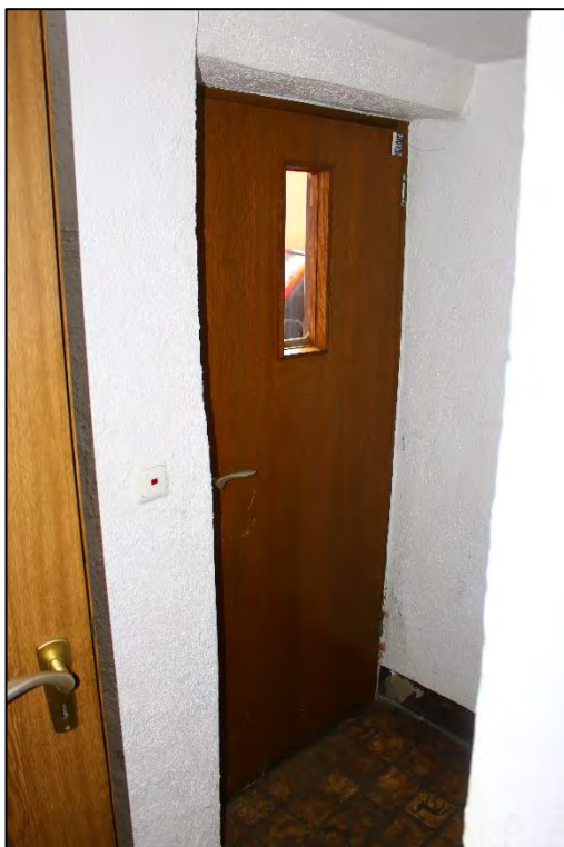
Foto Nr. 8: Gemeinschaftstreppe, Erdgeschoss, Hofausgang
