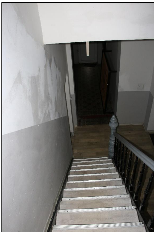
Foto Nr. 14: Gemeinschaftstreppehaus
