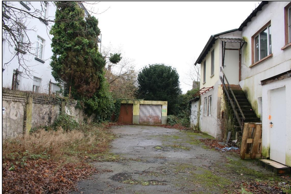
Foto Nr. 7: Hoffläche / Garagen / Nebengebäude
