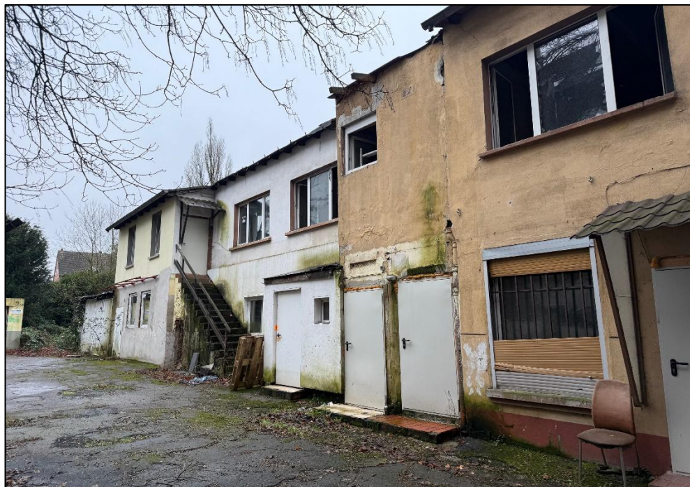
Foto Nr. 8: Nebengebäude
