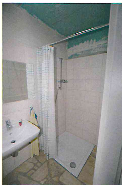
Im Ausbau befindliches Bad
