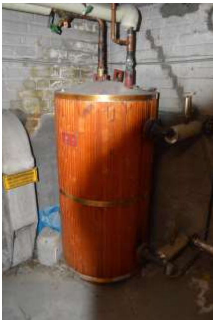
Bild 7: Brauchwassererwärmer
