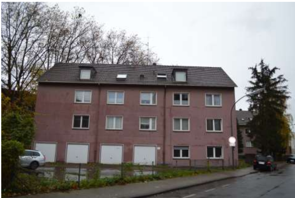
Bild 8: Südwestansicht Haus Nr. 74
