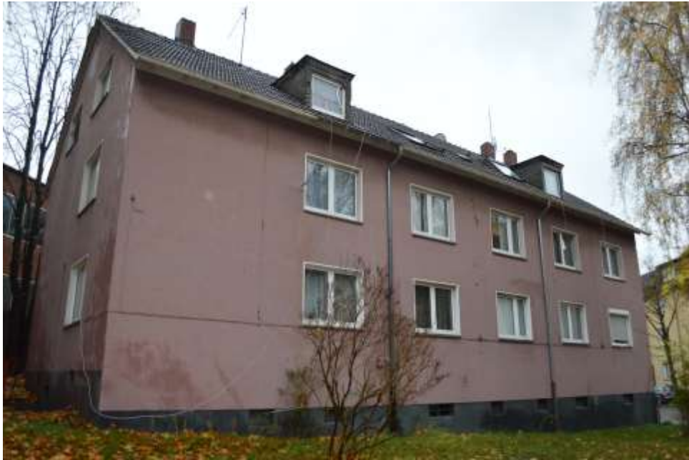
Bild 5: Westansicht Haus Nr. 72
