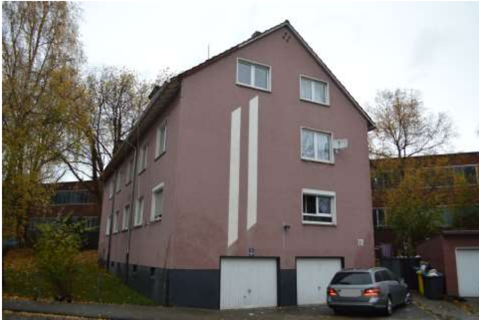
Bild 3: Südansicht Haus Nr. 72
