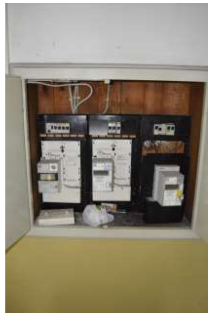
Bild 8: Bsp. Zähler-/Sicherungskasten
