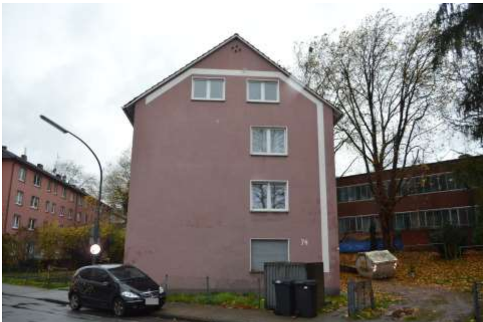
Bild 6: Südansicht Haus Nr. 74
