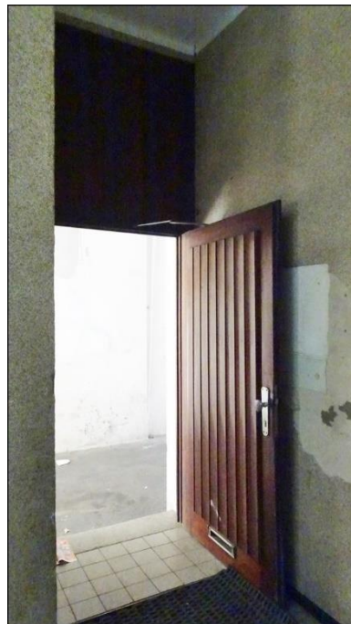
8) Zugang Treppenhaus von der Durchfahrt
