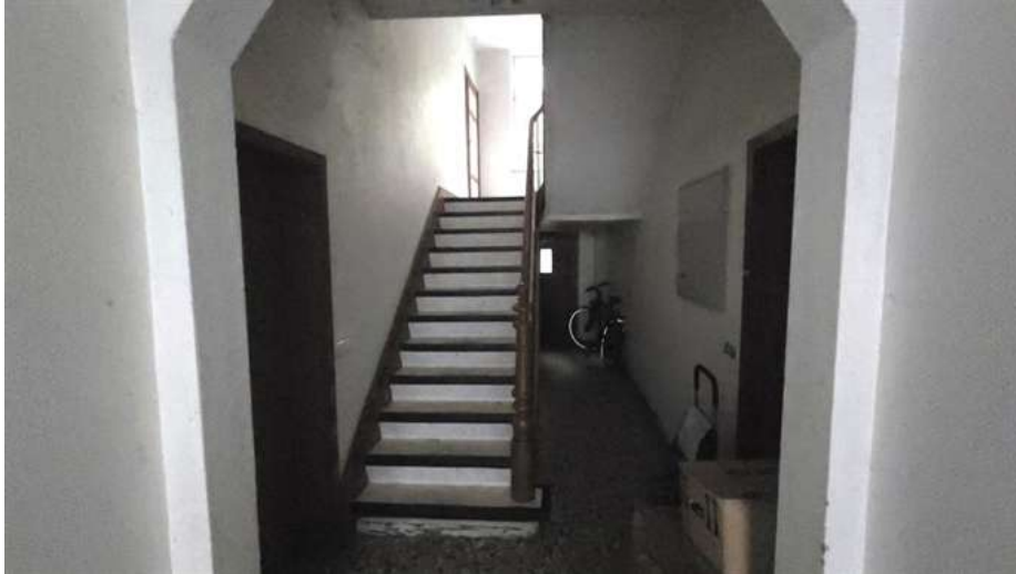
Treppenhaus, Zugang zu den WE 1 und 2 sowie Blick auf die hofseitige Nebeneingangstür.
