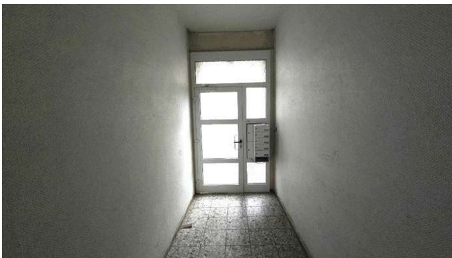
Hausflur mit Blick auf die Hauseingangstüranlage.
