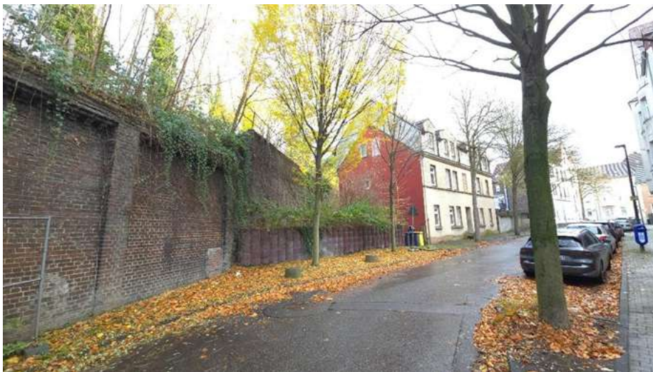
Straßenseitige Ansicht der Mauer und des Mehrfamilienhauses.
