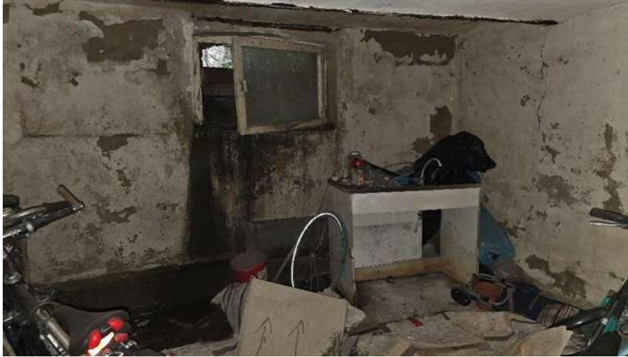
KG; Vermüllter Kellerraum mit Fenster, Kappendecke.
