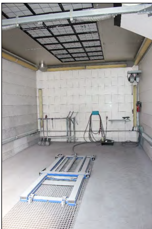
Foto Nr. 64: Werkstattgebäude, Lackierraum
