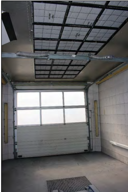
Foto Nr. 65: Werkstattgebäude, Lackierraum
