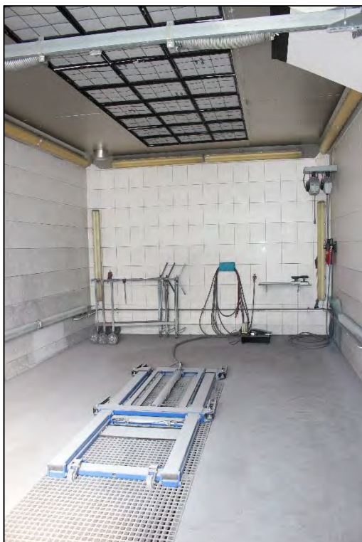
Foto Nr. 64: Werkstattgebäude, Lackierraum
