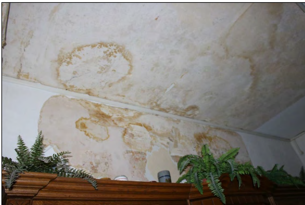
Foto Nr. 47: 3. OG, WE Nr. 4, Feuchteschäden Arbeitszimmer 2
