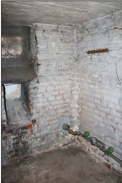
Foto Nr. 9: Kellergeschoss, Wasserhausanschluss
