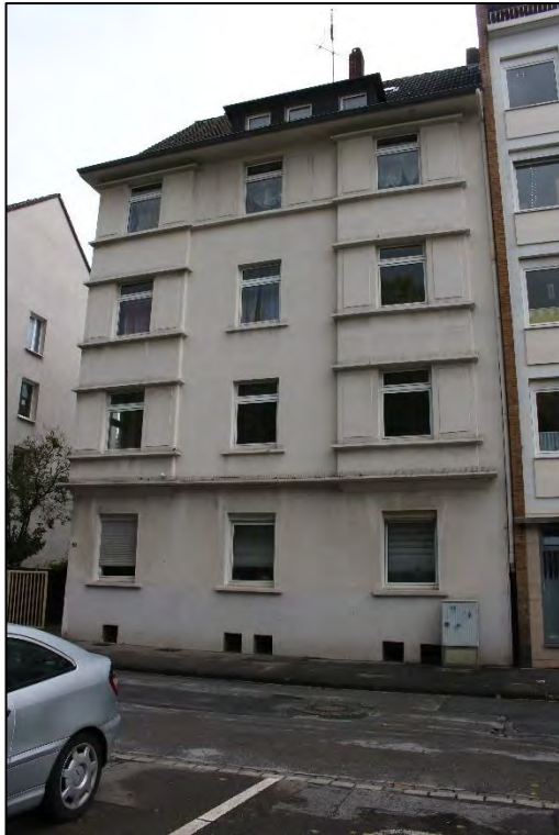
Foto Nr. 1: Straßenfassade
