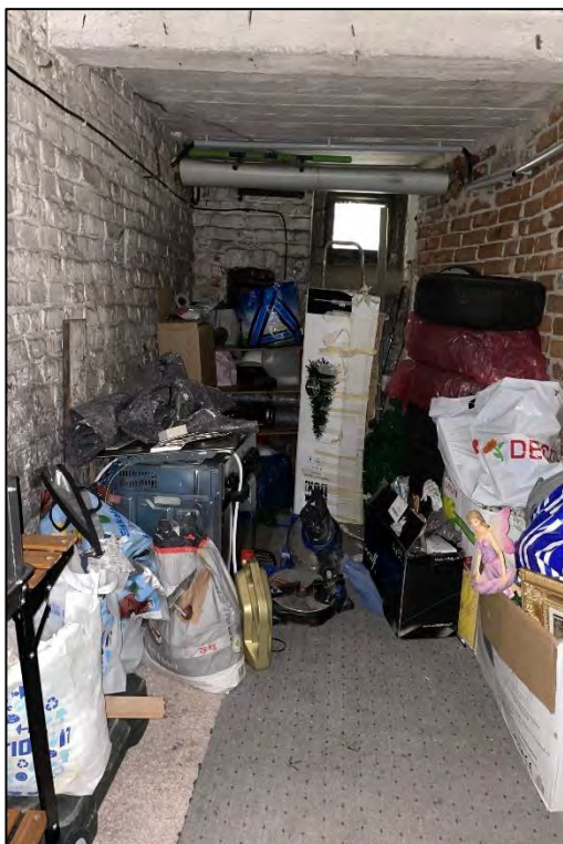
Foto Nr. 18: Kellergeschoss, Kellerraum
