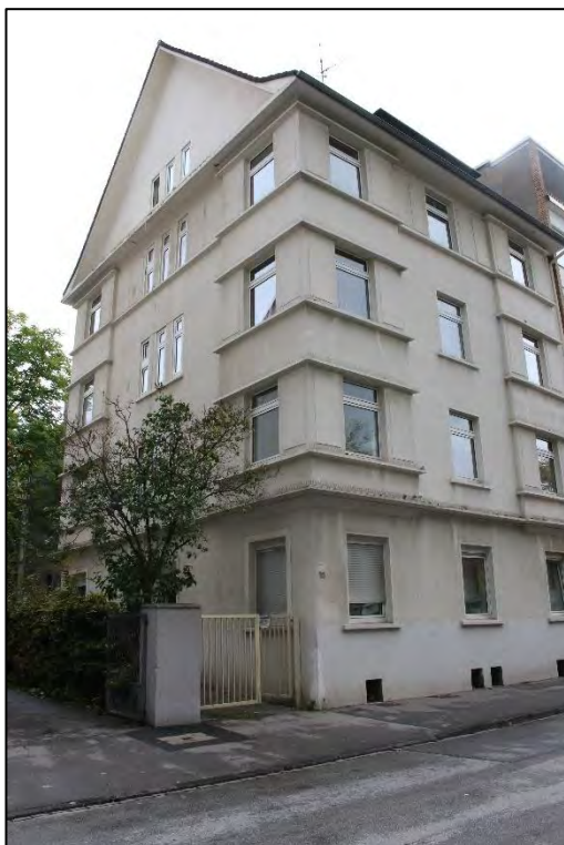
Foto Nr. 2: Straßen- und Seitenfassade
