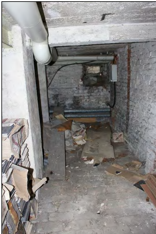
Foto Nr. 15: Kellergeschoss, Kellerraum
