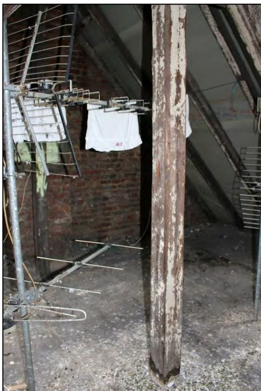
Foto Nr. 64: Dachboden
