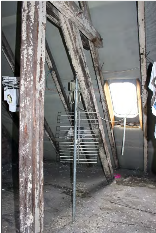
Foto Nr. 65: Dachboden
