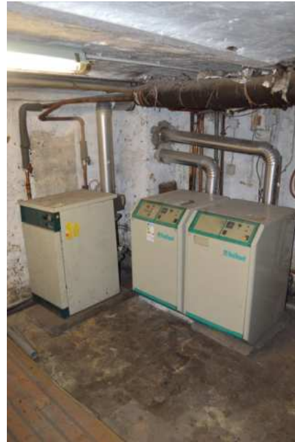
Bild 6: Gasheizungen
