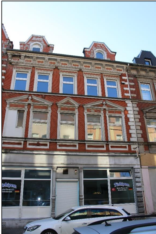
Foto Nr. 1: Straßenfassade, Wiehagen 35
