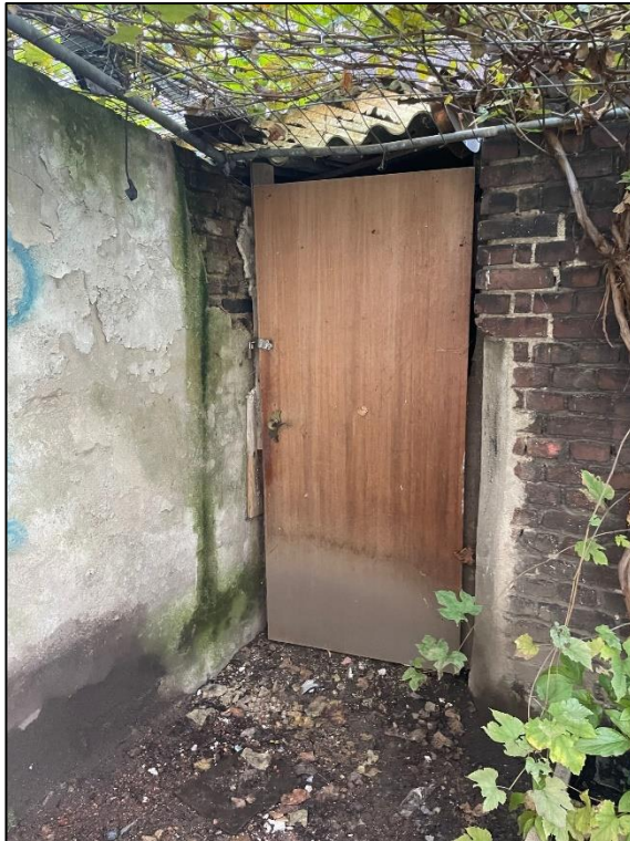
Foto Nr. 11: Eingang Anbau, Wiehagen 35
