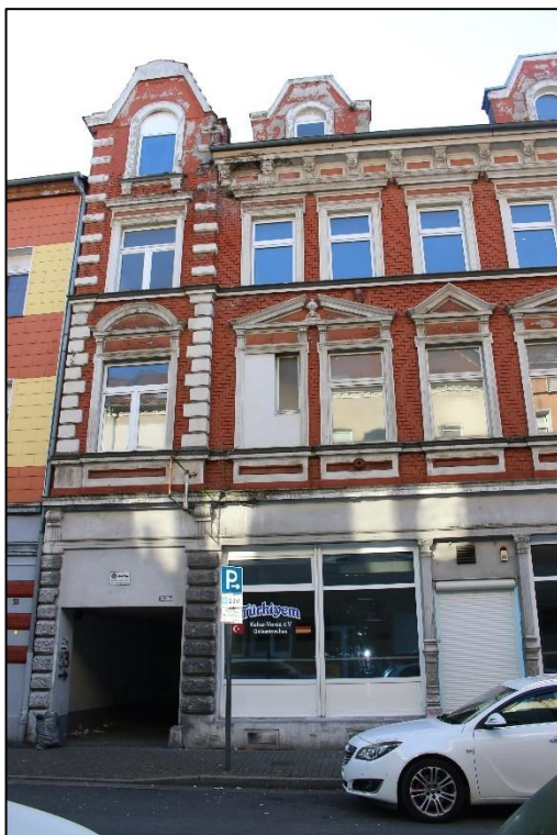
Foto Nr. 2: Straßenfassade, Wiehagen 35
