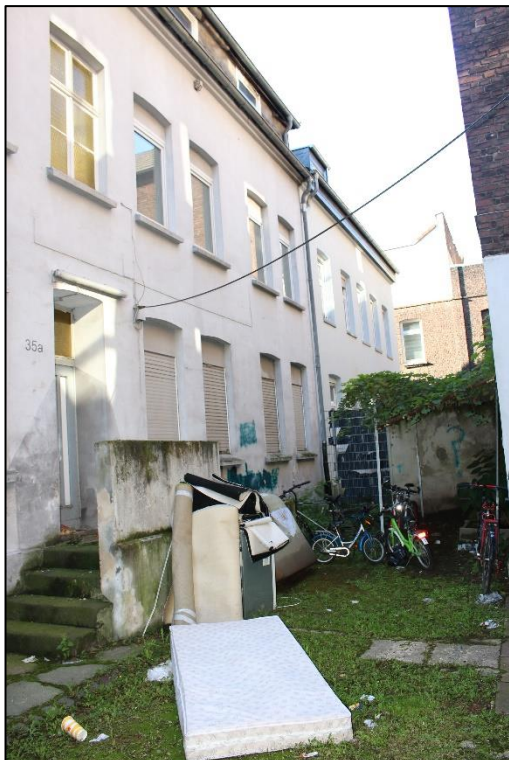
Foto Nr. 16: Eingangsfassade / Hoffläche, Wiehagen
