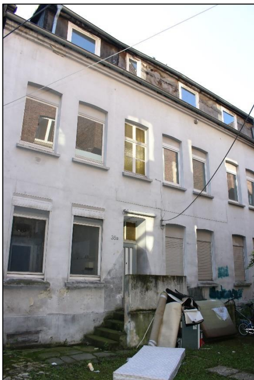
Foto Nr. 12: Eingangsfassade, Wiehagen 35a
