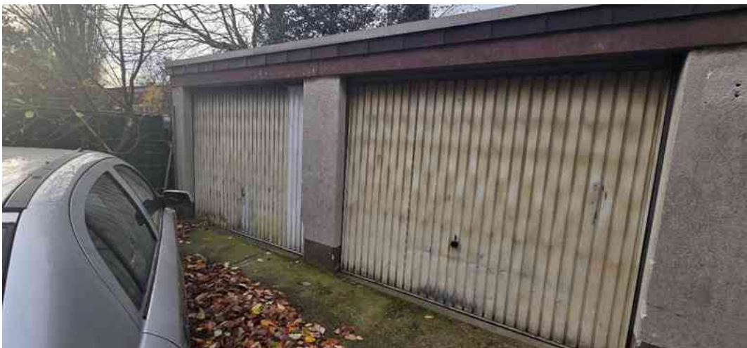
Blick auf das Wertermittlungsobjekt (hintere Garage).
