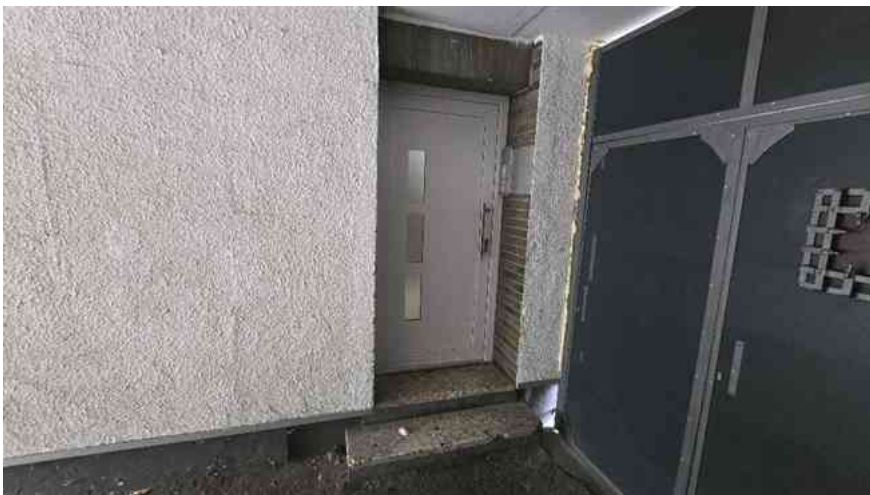
Blick auf die Hauseingangstür.
