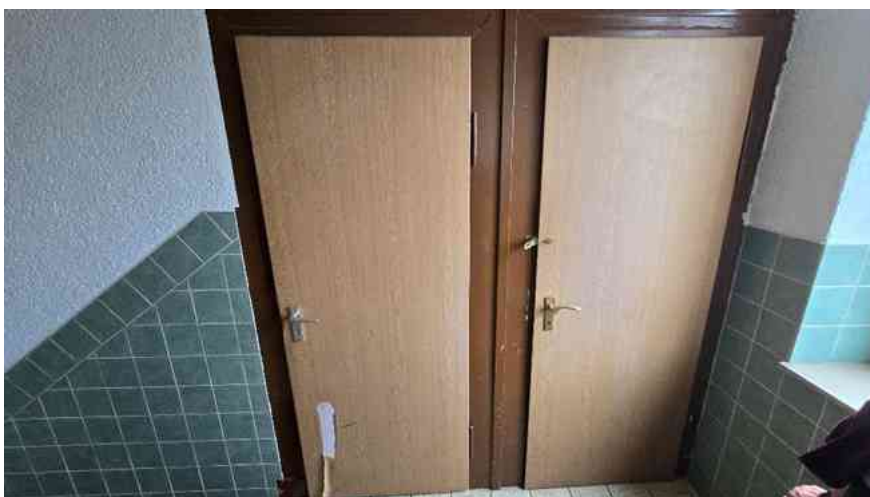
Blick auf die Türen zu den Podesträumen (Zubehörräume) zu SE 4.
