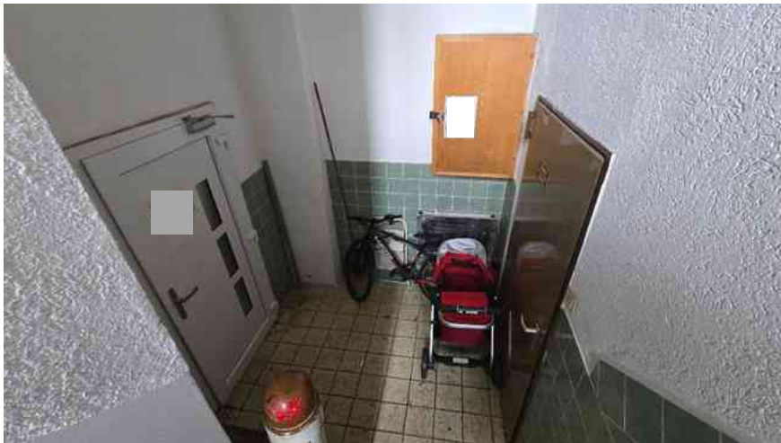
Blick auf die Hauseingangstür.
