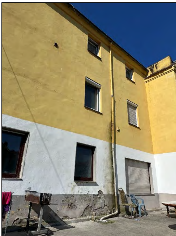
Foto Nr. 8: Gartenfassade / Feuchteschäden, Terrasse
