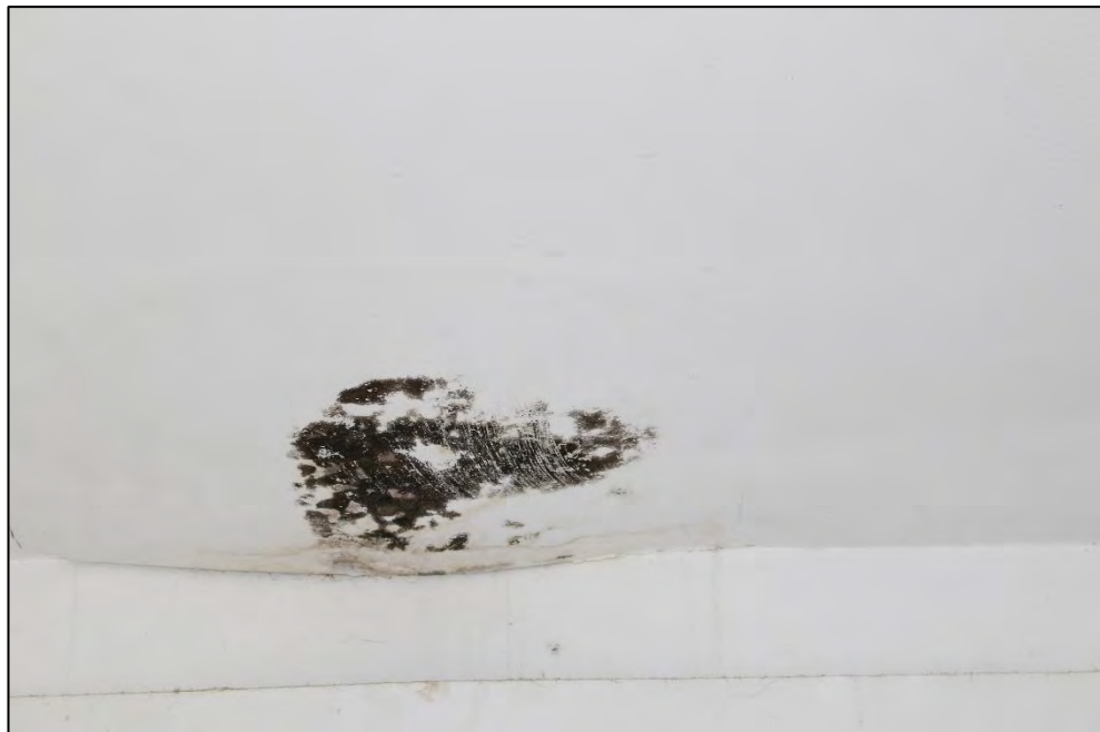
Foto Nr. 42: DG rechts, WE Nr. 4, Küche / Feuchteschaden Decke
