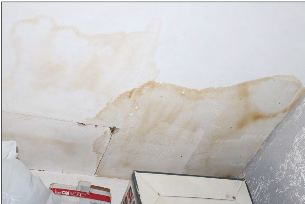
Foto Nr. 52: DG links, WE Nr. 5, Küche / Feuchteschäden
