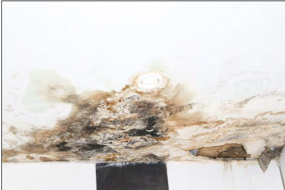
Foto Nr. 31: 1. OG links, WE Nr. 3, Duschbad / Feuchteschaden Decke
