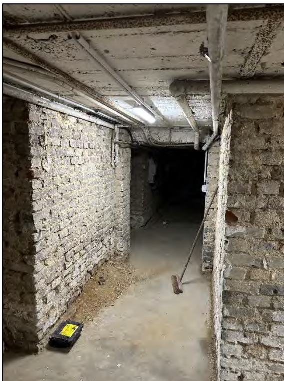
Foto Nr. 14: Kellergeschoss, Kellerflur
