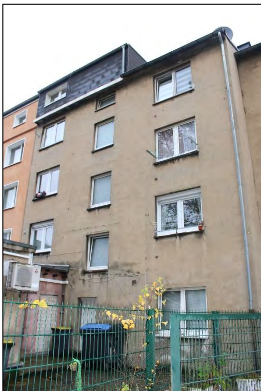
Foto Nr. 4: Hoffassade
