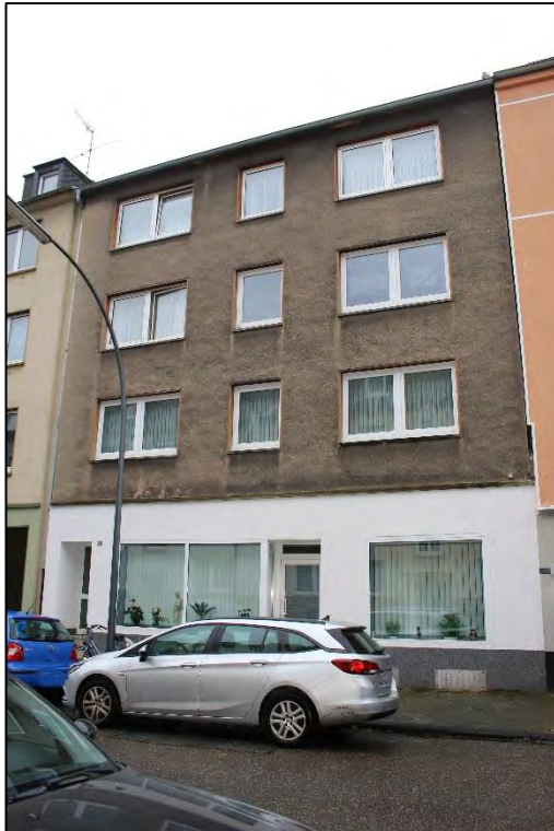
Foto Nr. 1: Straßenfassade
