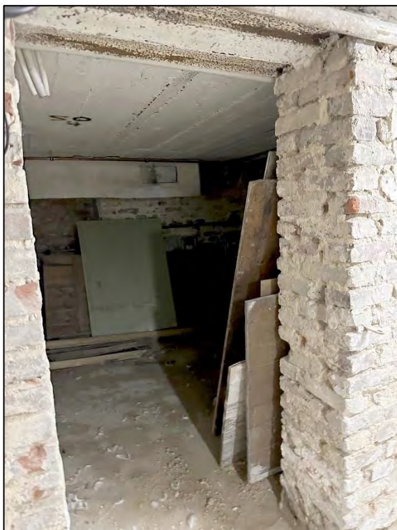
Foto Nr. 16: Kellergeschoss, Kellerraum
