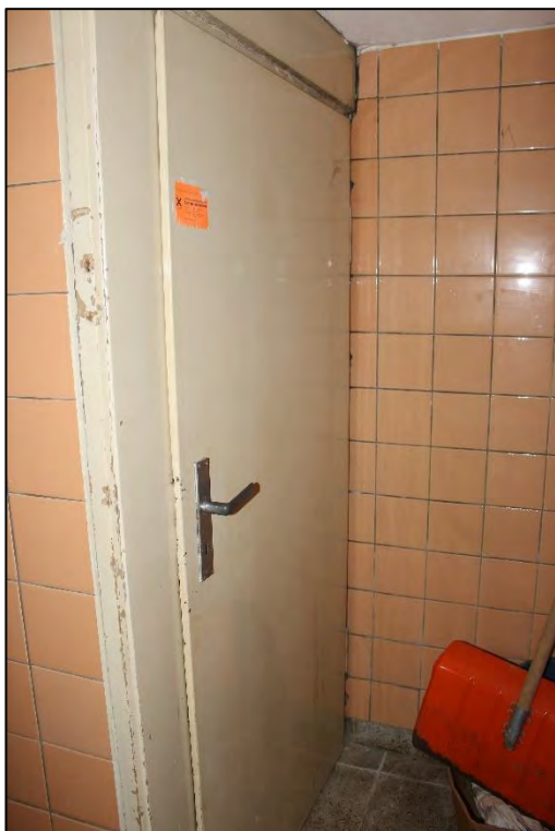
Foto Nr. 12: Erdgeschoss, Gemeinschaftstreppenhaus, Tür Kellerabgang
