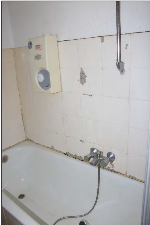
Foto Nr. 35: Dachgeschoss, ETW Nr. 7, Bad
