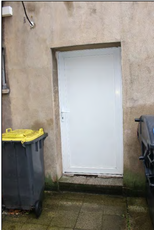
Foto Nr. 7: Hofausgang Wohnhaus
