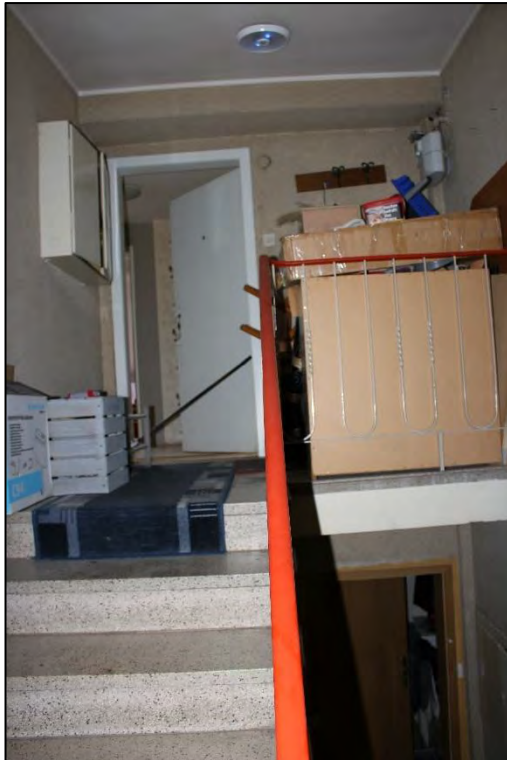
Foto Nr. 21: Gemeinschaftstreppe, Dachgeschoss, Zugang ETW Nr. 7
