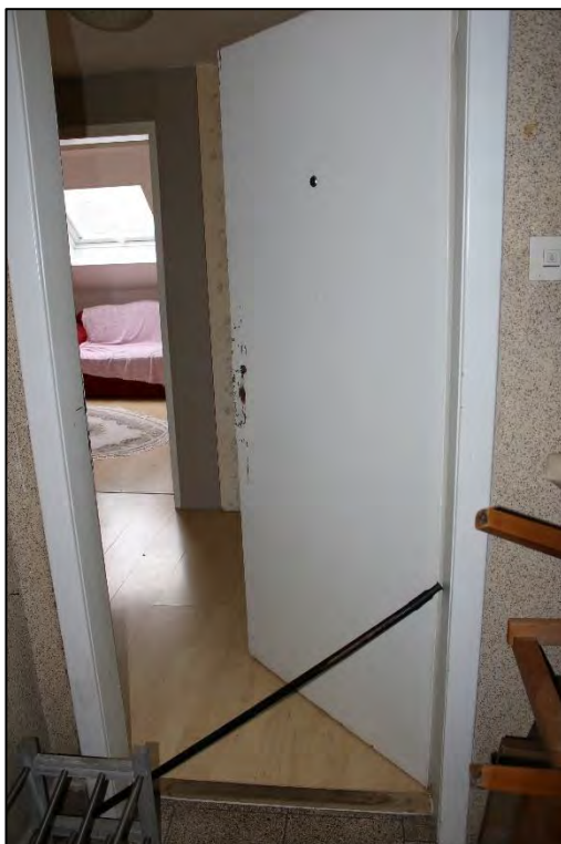
Foto Nr. 22: Gemeinschaftstreppe, Dachgeschoss, Zugang ETW Nr. 7
