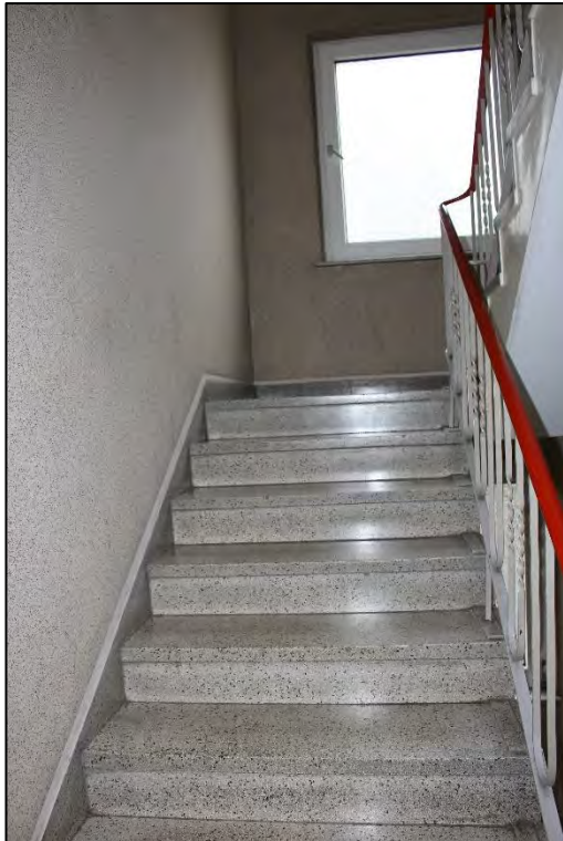
Foto Nr. 19: Gemeinschaftstreppehaus
