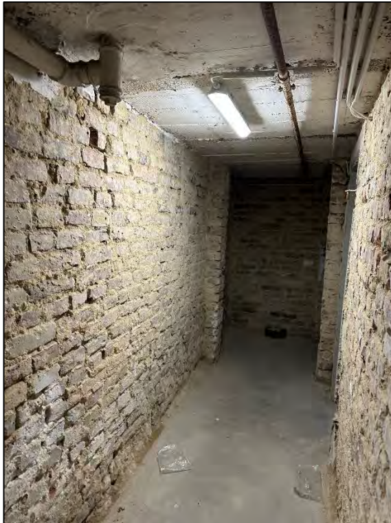
Foto Nr. 17: Kellergeschoss, Kellerflur
