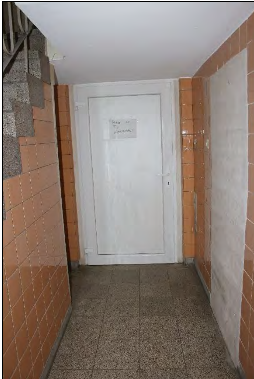
Foto Nr. 11: Erdgeschoss, Gemeinschaftstreppenhaus, Hofausgang
