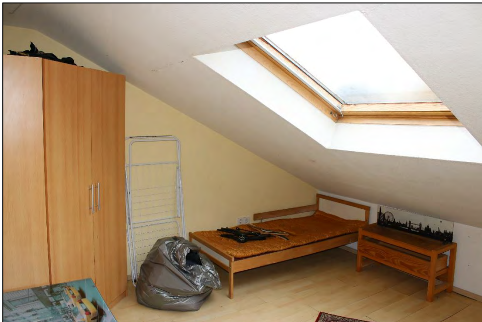
Foto Nr. 38: Dachgeschoss, ETW Nr. 7, Kinderzimmer 2
