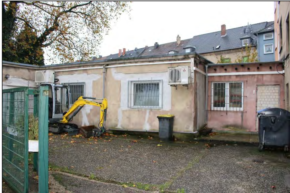
Foto Nr. 5: Hoffläche / Nebengebäude
