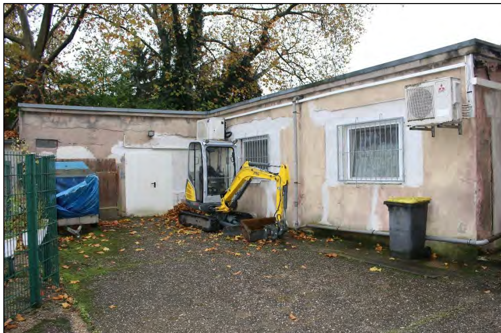
Foto Nr. 6: Hoffläche / Nebengebäude
