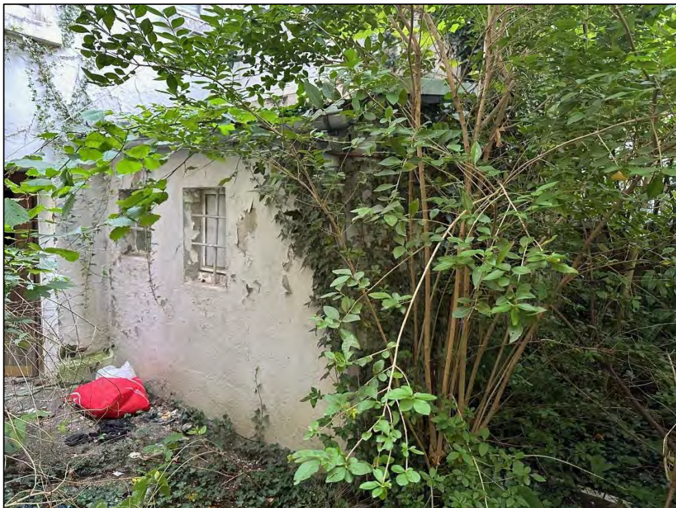
Foto Nr. 12: Gartenfassade / Anbau Gewerbeeinheit links
