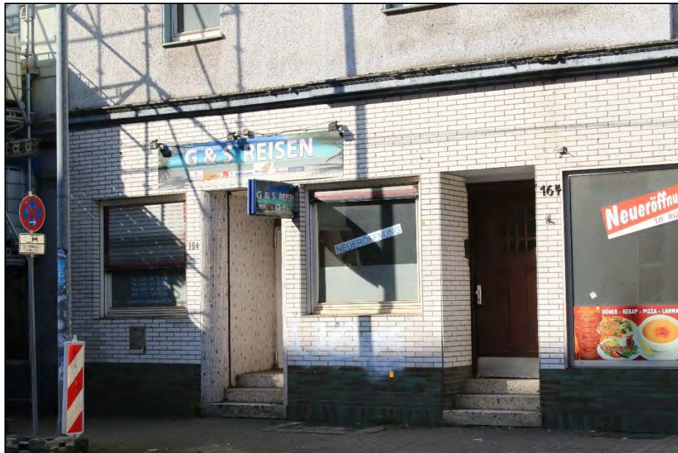
Foto Nr. 5: Straßenfassade, Gewerbeeinheit links
