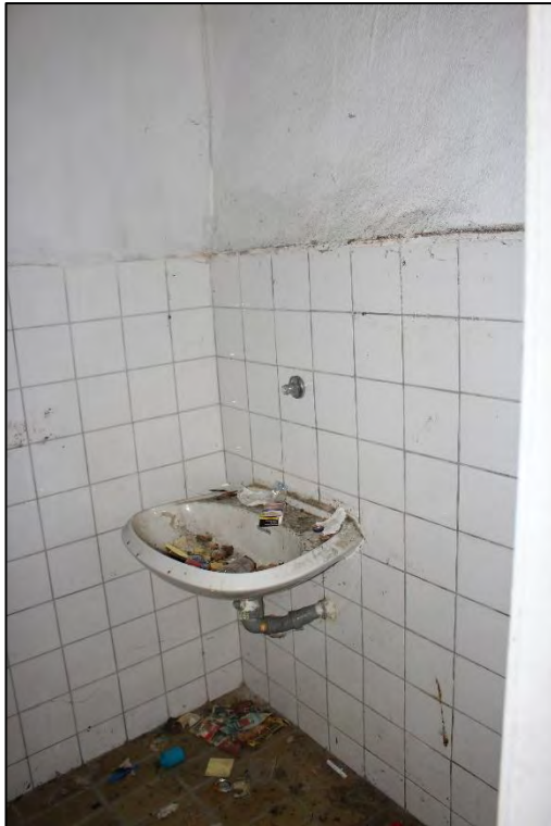
Foto Nr. 33: Gewerbeinheit links, Erdgeschoss, WC
