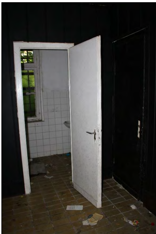
Foto Nr. 32: Gewerbeeinheit links, Erdgeschoss, Vorraum WC
