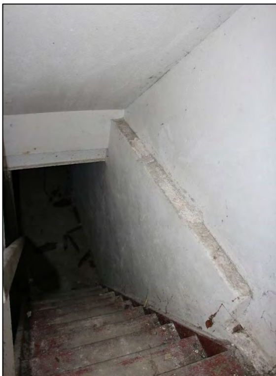
Foto Nr. 18: Treppe zum Kellergeschoss
