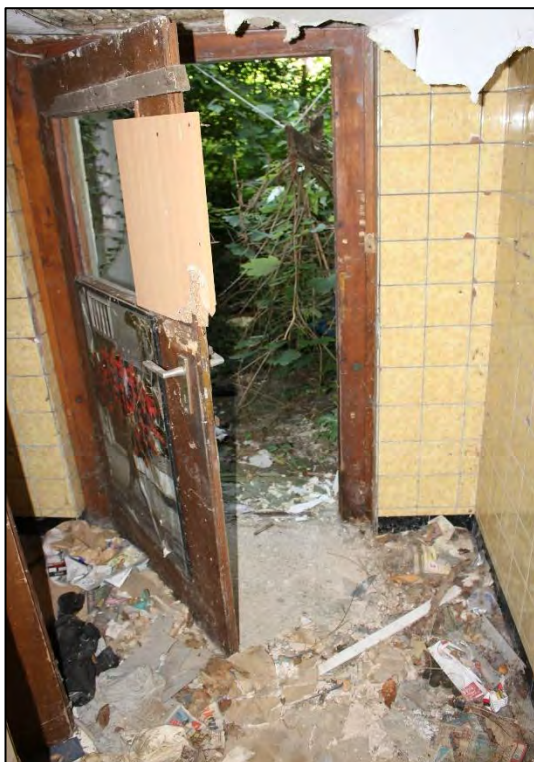
Foto Nr. 16: Gemeinschaftstreppe, Hofausgang
