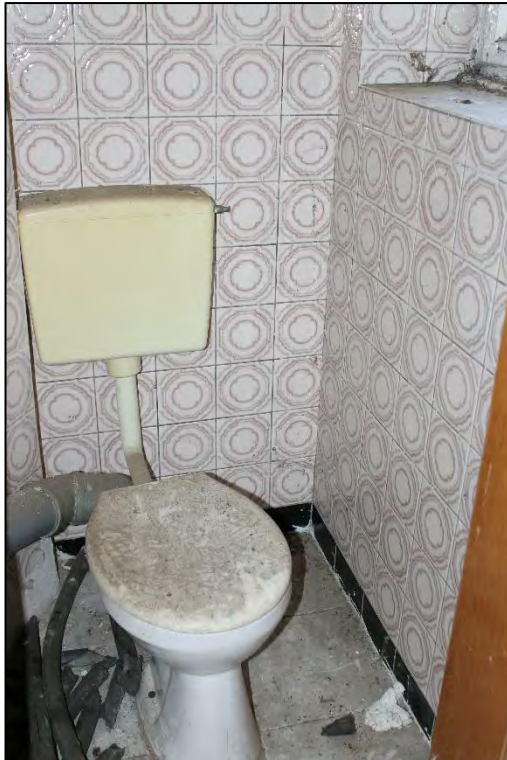
Foto Nr. 37: Gemeinschaftstreppe, WC, Treppenpodest zum 1. OG
