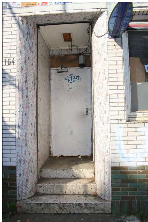
Foto Nr. 6: Straßenfassade, Gewerbeeinheit links, Eingang
