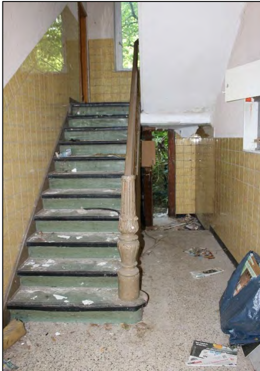
Foto Nr. 15: Gemeinschaftstreppe, Hofausgang
