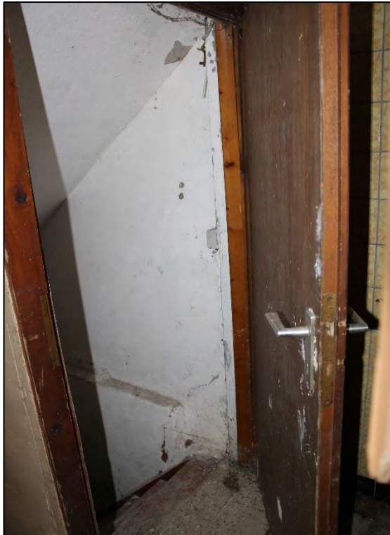
Foto Nr. 17: Gemeinschaftstreppe, Tür zum Kellerabgang
