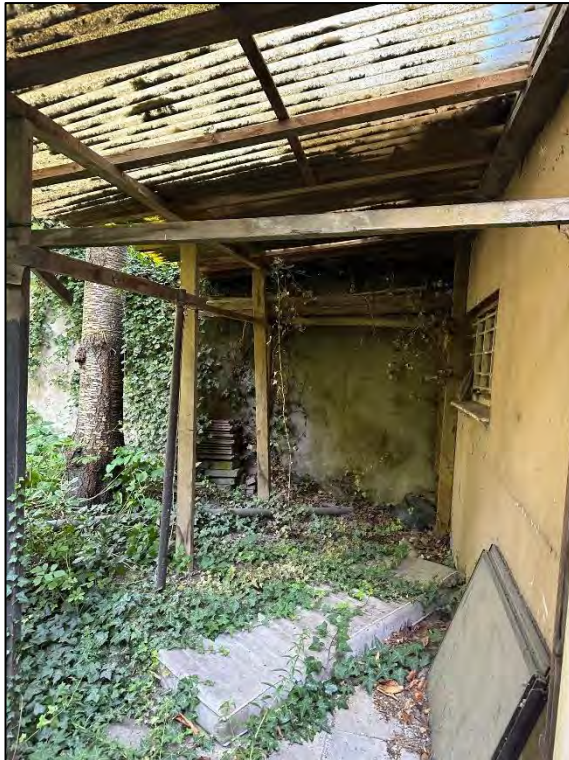
Foto Nr. 9: Überdachung, Gartenbereich
