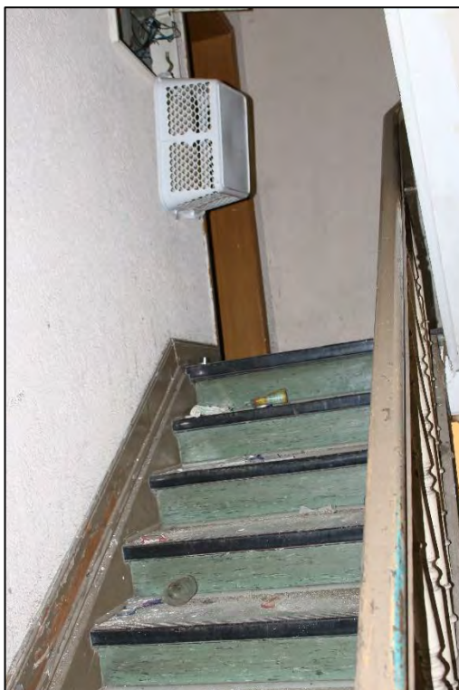
Foto Nr. 38: Gemeinschaftstreppe, 1. OG
