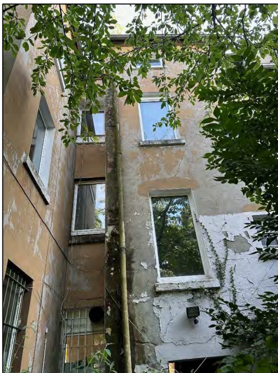
Foto Nr. 8: Gartenfassade
