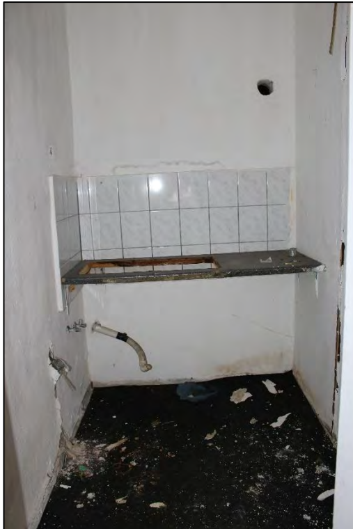
Foto Nr. 31: Gewerbeeinheit links, Erdgeschoss, Teeküche
