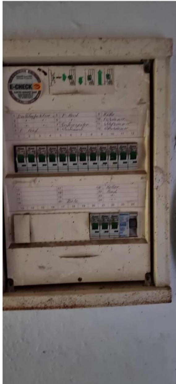
WE 2M: Diele; Elektro-Unterverteilung mit Sicherungsautomaten.
