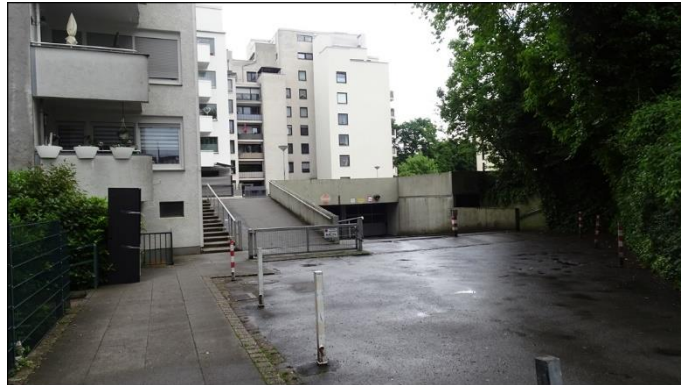
4) Zufahrt Tiefgarage/ Auffahrt zum Tiefgaragendach
