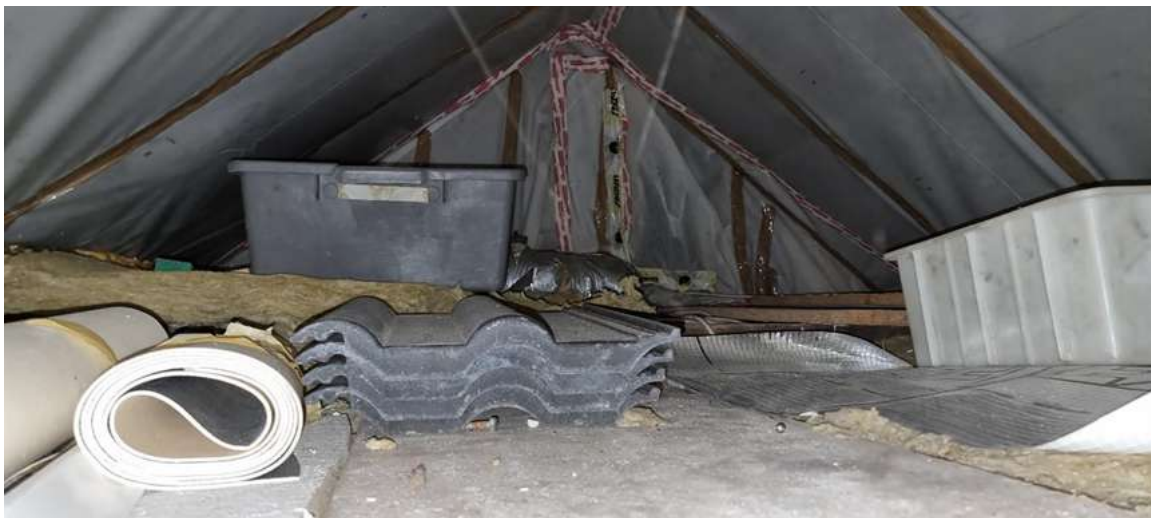
Blick in den Spitzboden.
