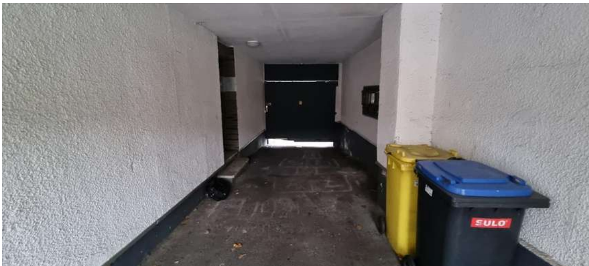
Hofdurchfahrt mit Briefkastenanlage.
