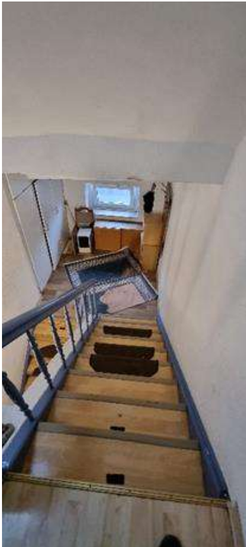
Blick vom Flur in den Treppenraum.
