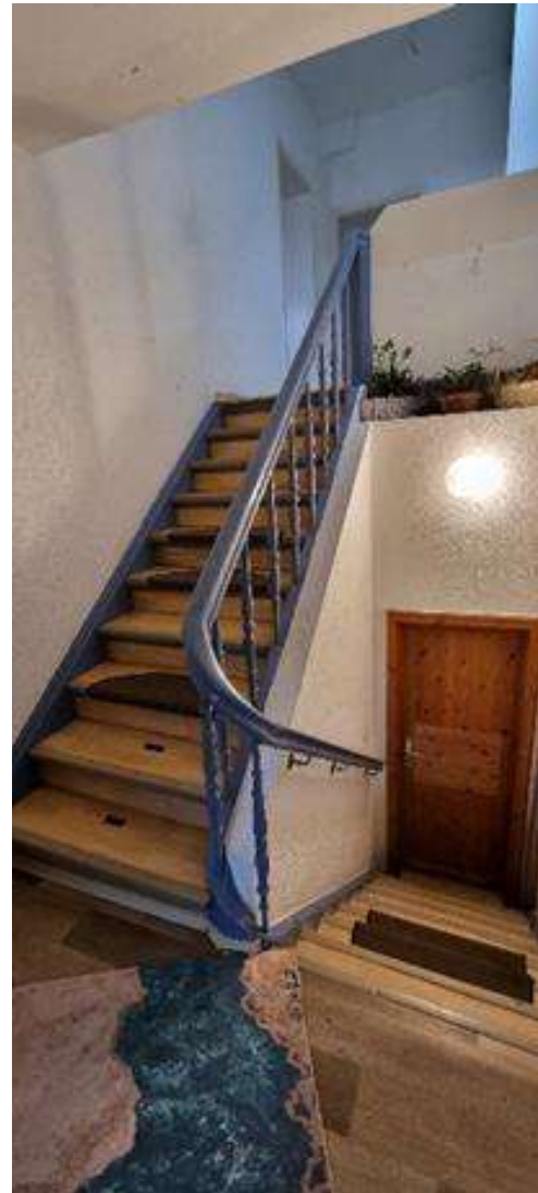
Blick auf die Wohnungsabschlusstür und den oberen Treppenlauf mit geringer lichter Höhe.
