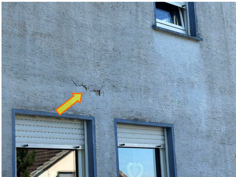
Außenputzschaden (Beispiel)
