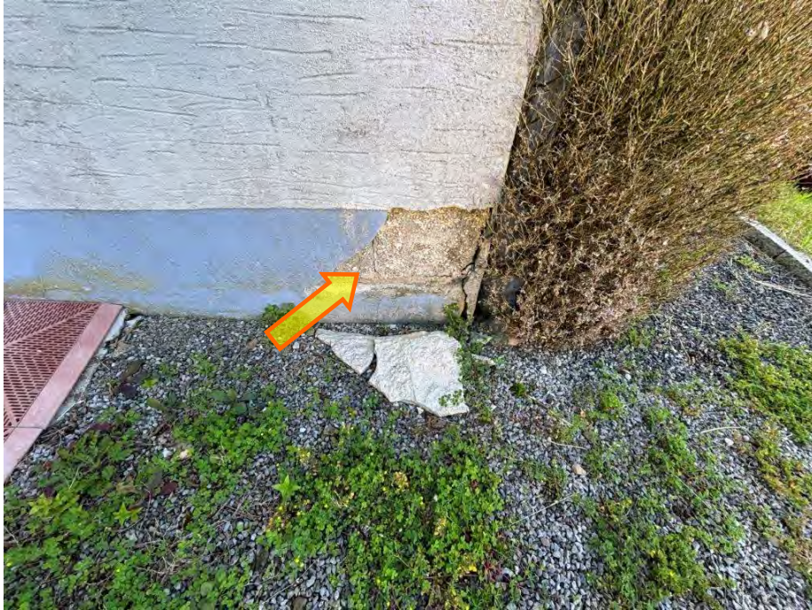
Außenputzschaden (Beispiel)
