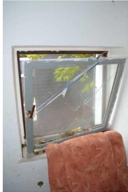
Bild 22: defektes Fenster DG
