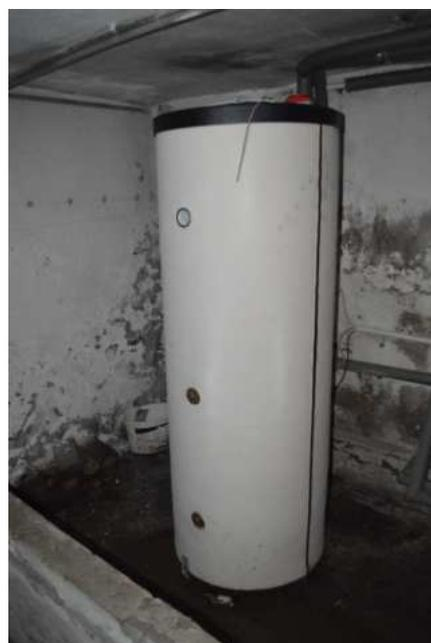
Bild 20: Warmwasserspeicher
