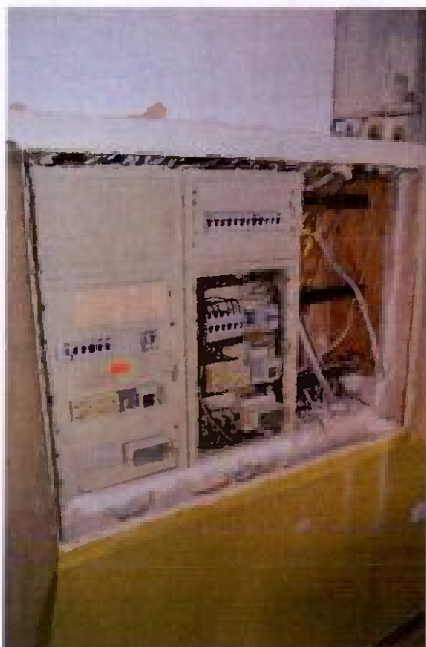
Bild 17: Elektrounterverteilung
