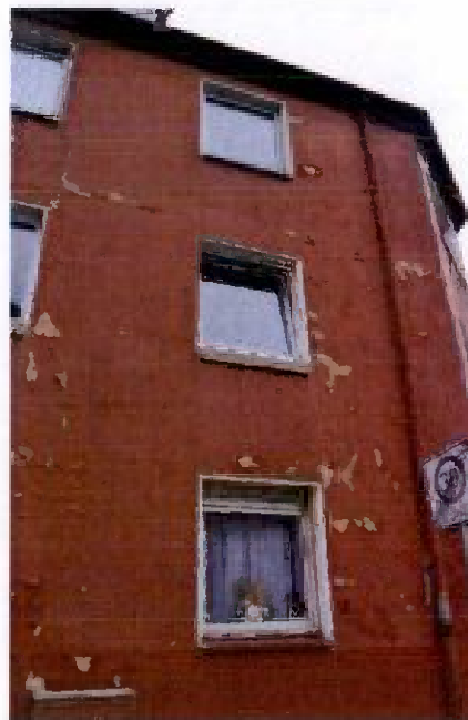
Bild 22: Abplatzungen Außenfassade
