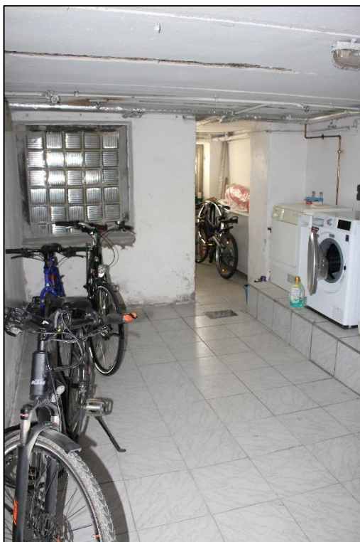
Foto Nr. 12: Kellergeschoss, Waschküche
