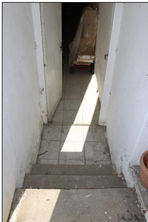
Foto Nr. 18: Kellergeschoss, Kelleraußeneingang
