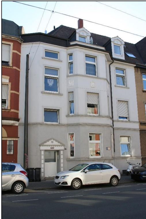
Foto Nr. 1: Straßenfassade
