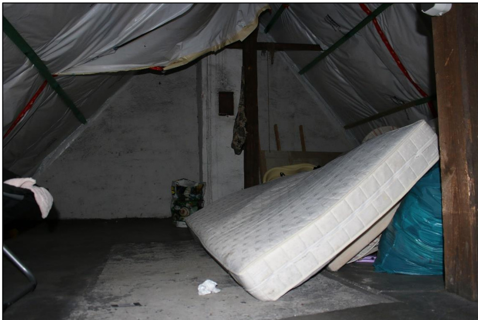
Foto Nr. 34: Dachboden, ETW Nr. 4
