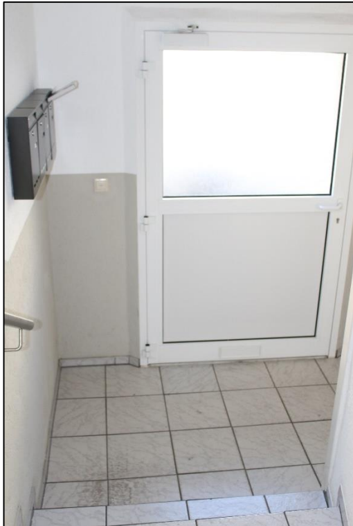
Foto Nr. 7: Gemeinschaftstreppehaus, Erdgeschoss
