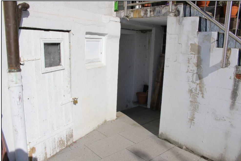
Foto Nr. 5: Kelleraußeneingang / Treppe zum Erdgeschoss
