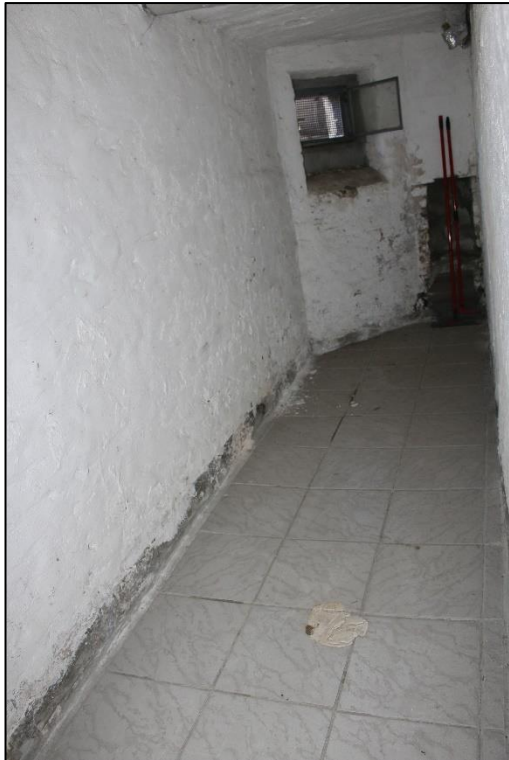
Foto Nr. 15: Kellergeschoss, Kellerraum
