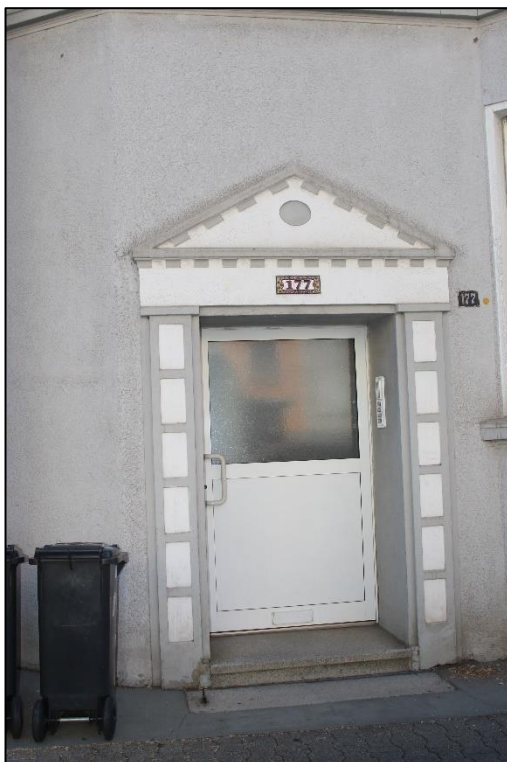
Foto Nr. 2: Hauseingang
