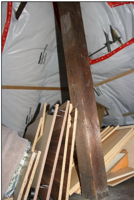
Foto Nr. 36: Dachboden, ETW Nr. 4
