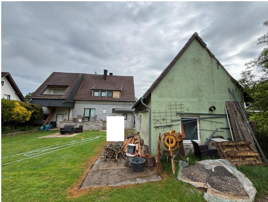
Gartenseitige Ansicht mit ehemaligem Stallgebäude
