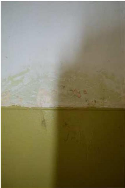
Bild 19: Feuchtigkeitsschäden
