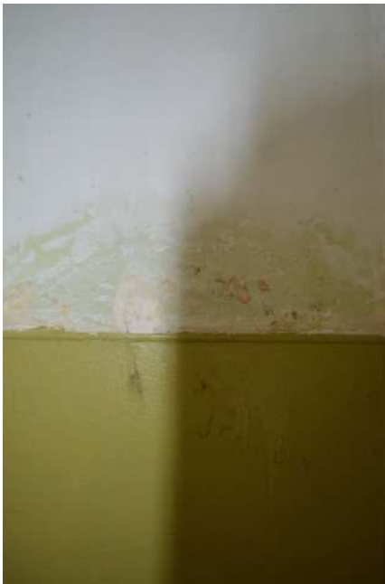
Bild 19: Feuchtigkeitsschäden Treppenhaus
