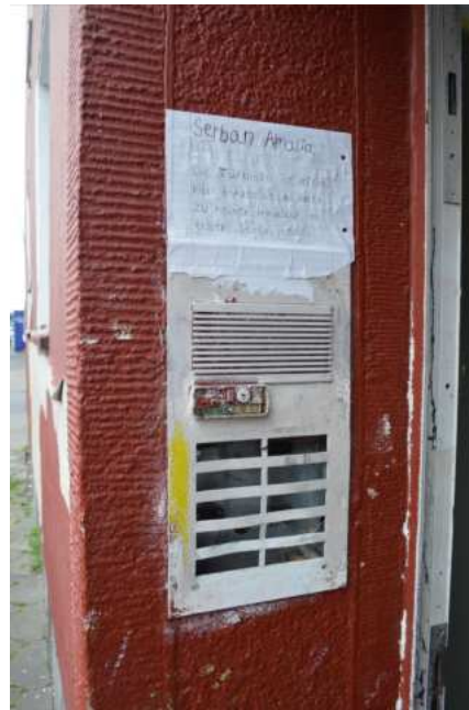
Bild 20: defekte Klingelanlage
