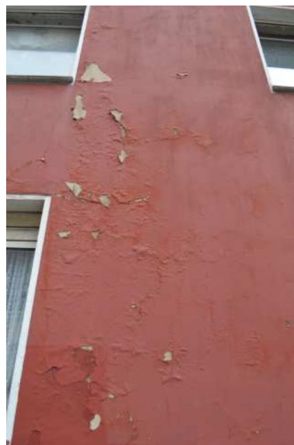
Bild 22: Abplatzungen Außenfassade
