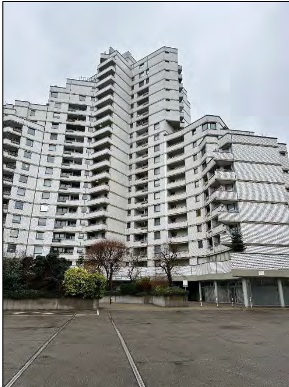
Foto Nr. 1: Hoffassade
