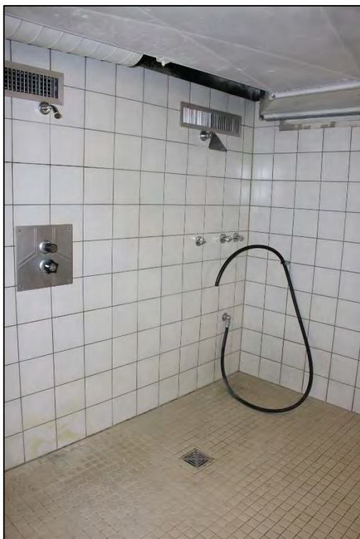
Foto Nr. 46: Teileigentum B 3, KG, Overwegstraße 32, Duschraum
