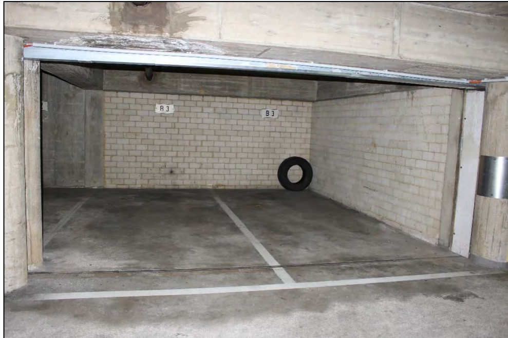
Foto Nr. 11: Tiefgaragenstellplätze B 3
