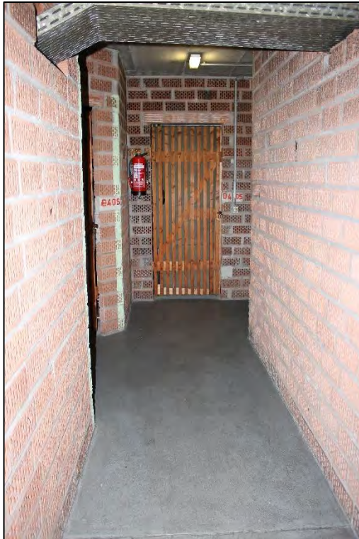
Foto Nr. 49: Teileigentum B 3, KG, Overwegstraße 32, Abstellräume / Flur
