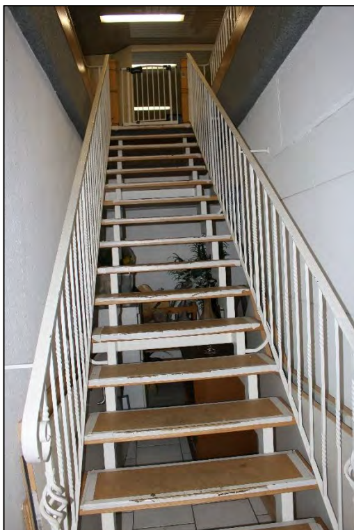
Foto Nr. 38: Teileigentum Nr. B 3, EG, Overwegstraße 32, Treppe zum Kellergeschoss
