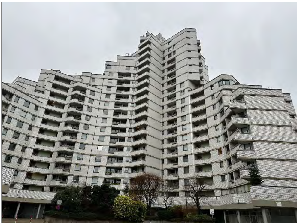
Foto Nr. 2: Hoffassade
