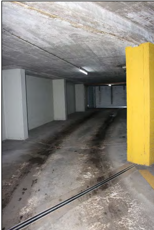
Foto Nr. 13: Tiefgaragenzufahrt
