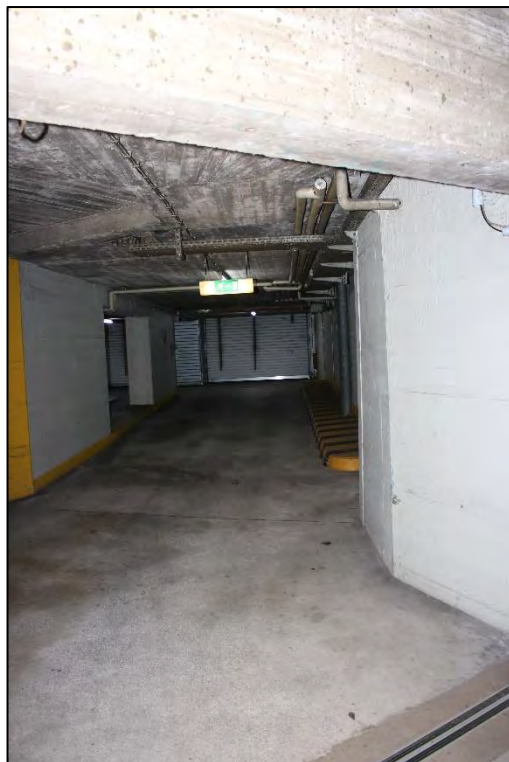
Foto Nr. 12: Tiefgaragenausfahrt
