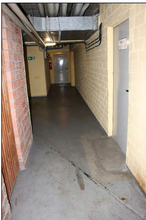
Foto Nr. 48: Teileigentum B 3, KG, Overwegstraße 32, Flur
