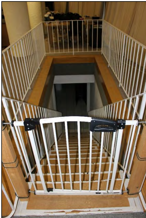
Foto Nr. 21: Teileigentum Nr. B 3, EG, Overwegstraße 32, Versamlungsraum, Treppe zum Kellergeschoss
