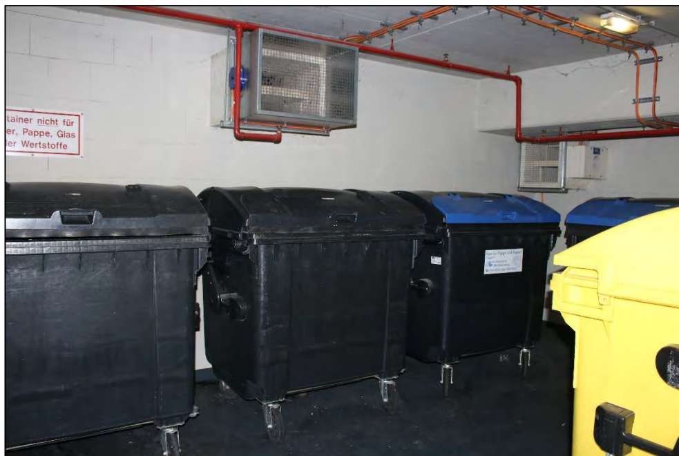
Foto Nr. 10: Müllagerraum, Overwegstraße 32, Kellergeschoss
