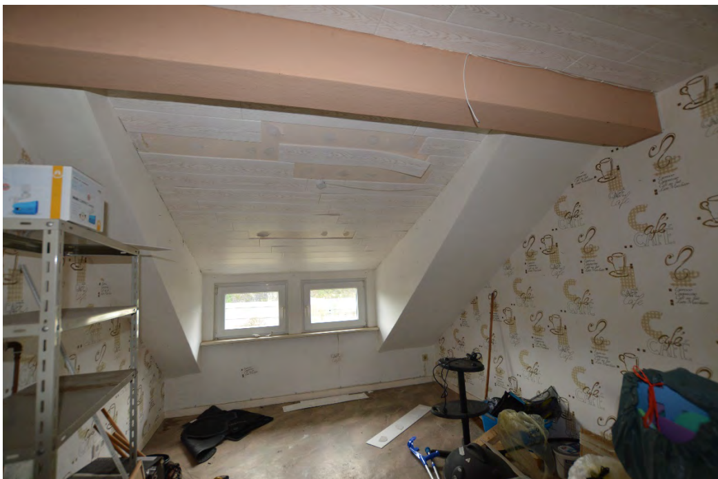
Ausgebauter Teil des Dachbodens
