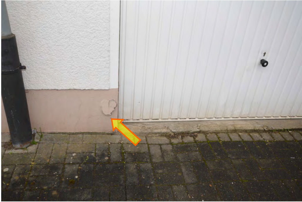
Außenputzschaden (Beispiel)
