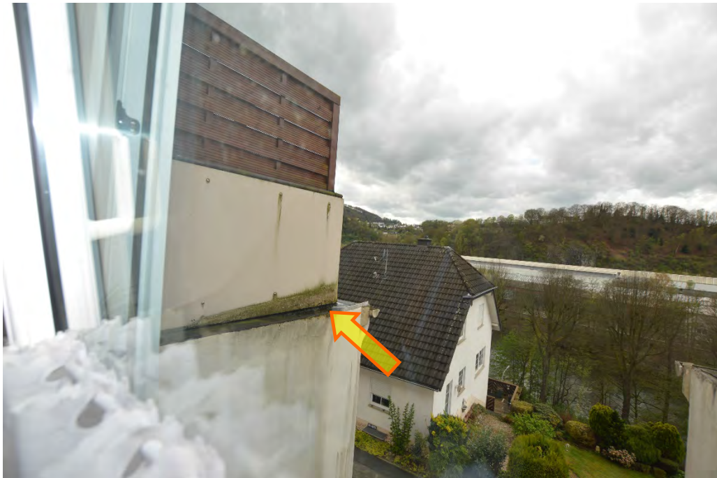
Außenputzverfärbung (Beispiel)
