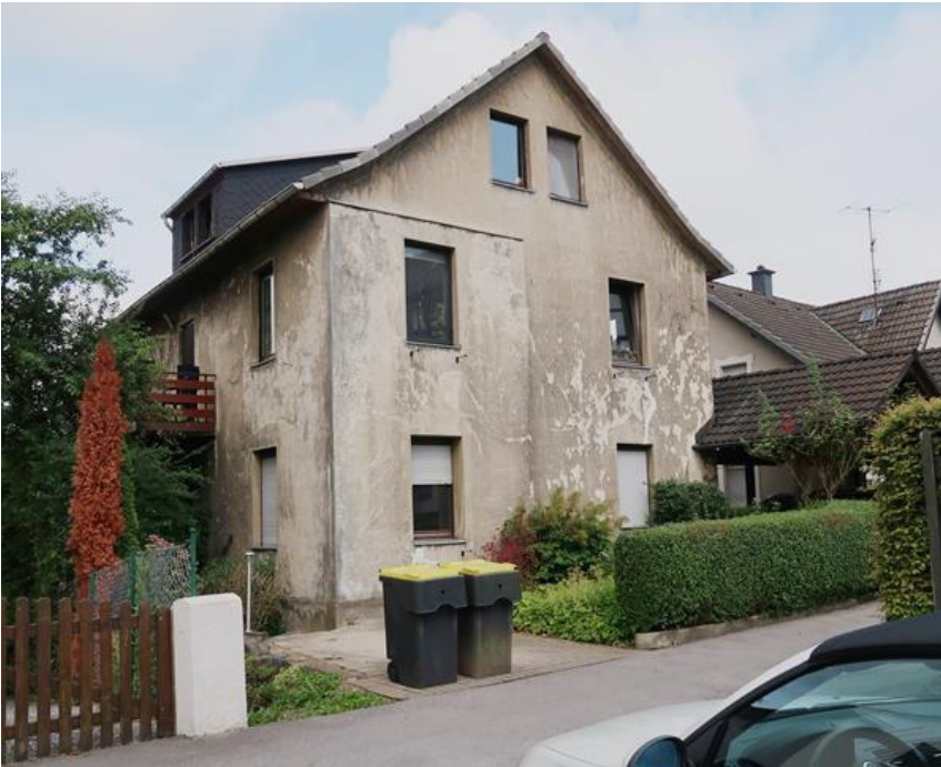
Ansicht von der Straße „In der Schledde“
