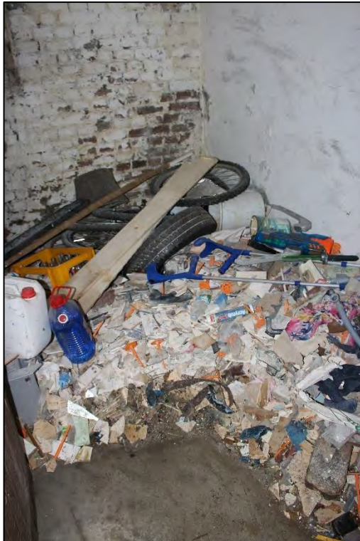
Foto Nr. 17: Dresdener Straße 28, Kellergeschoss, Kellerraum
