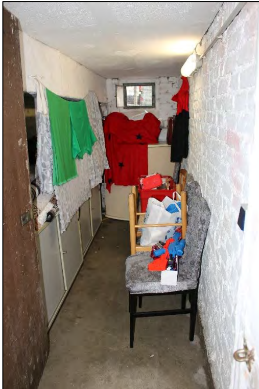
Foto Nr. 19: Dresdener Straße 28, Kellergeschoss, Kellerraum
