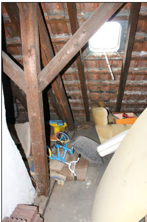
Foto Nr. 54: Dresdener Straße 28, Dachboden
