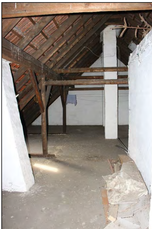
Foto Nr. 52: Dresdener Straße 28, Dachboden
