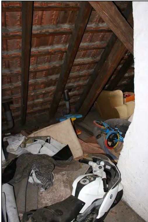
Foto Nr. 51: Dresdener Straße 28, Dachboden
