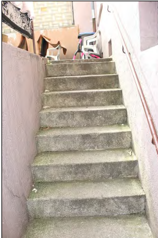
Foto Nr. 5: Kelleraußeneingang
