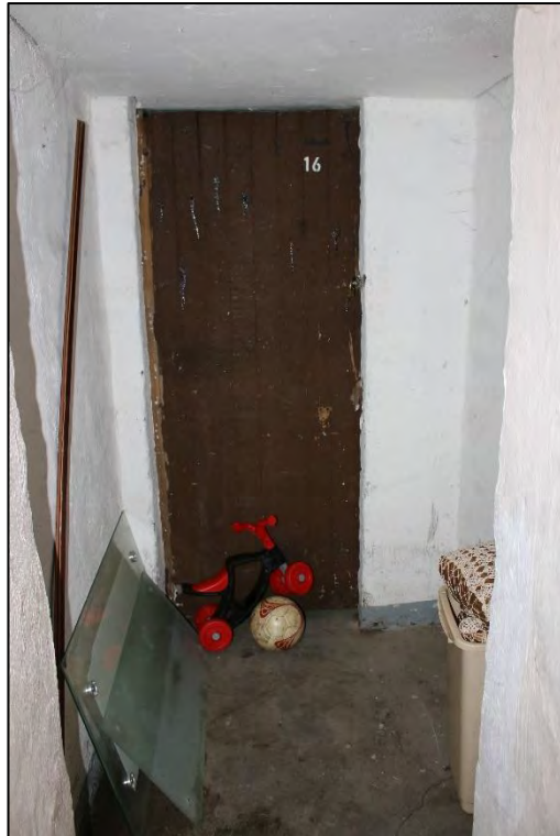
Foto Nr. 11: Dresdener Straße 28, Kellergeschoss, Flur
