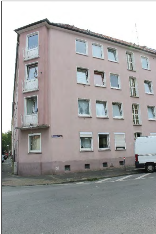
Foto Nr. 3: Straßenfassade Dresdener Straße 28
