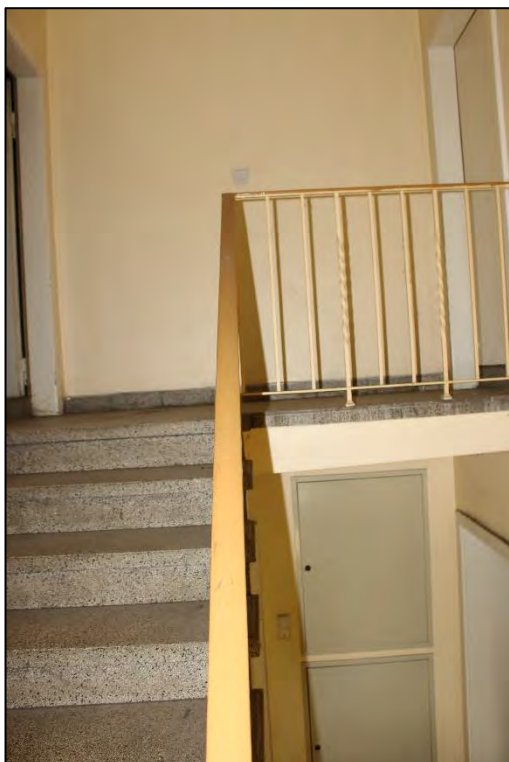
Foto Nr. 50: Dresdener Straße 28, Gemeinschaftstreppehaus, Dachgeschoss
