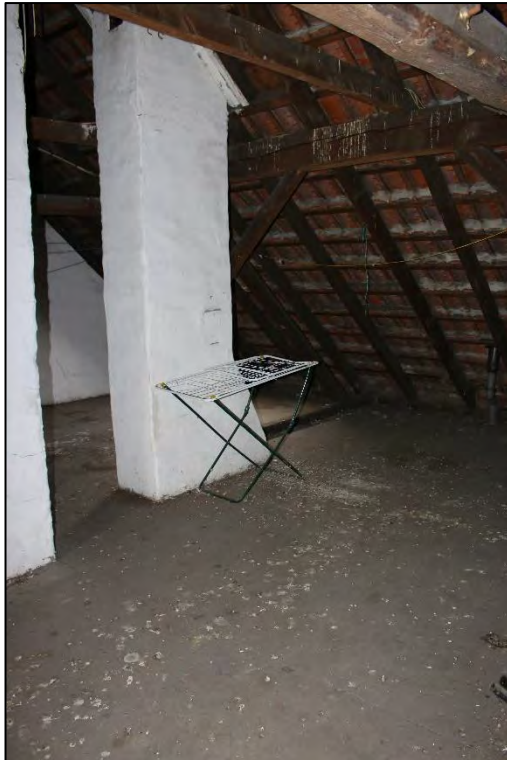
Foto Nr. 53: Dresdener Straße 28, Dachboden
