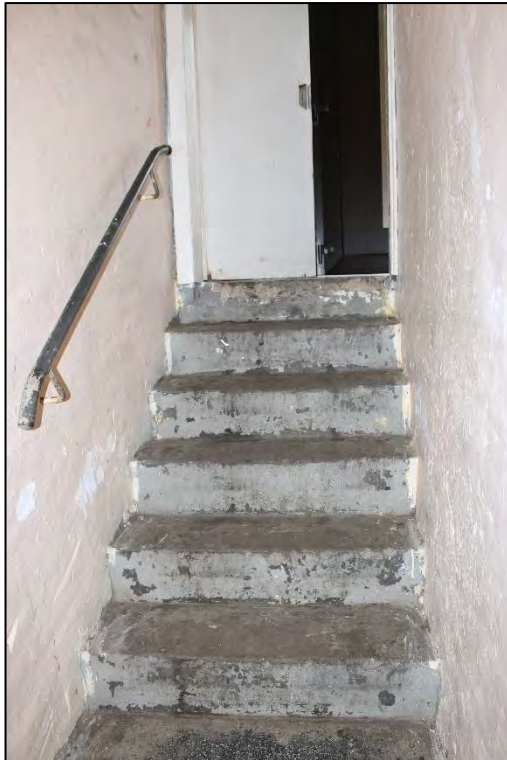
Foto Nr. 9: Dresdener Straße 28, Treppe zum Kellergeschoss
