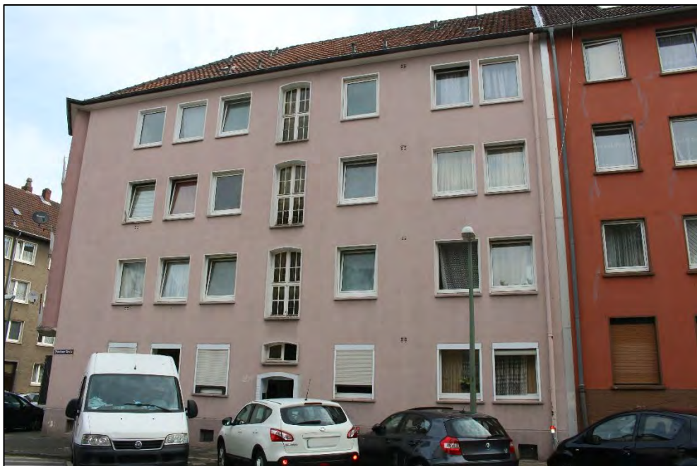
Foto Nr. 2: Straßenfassade Dresdener Straße 28
