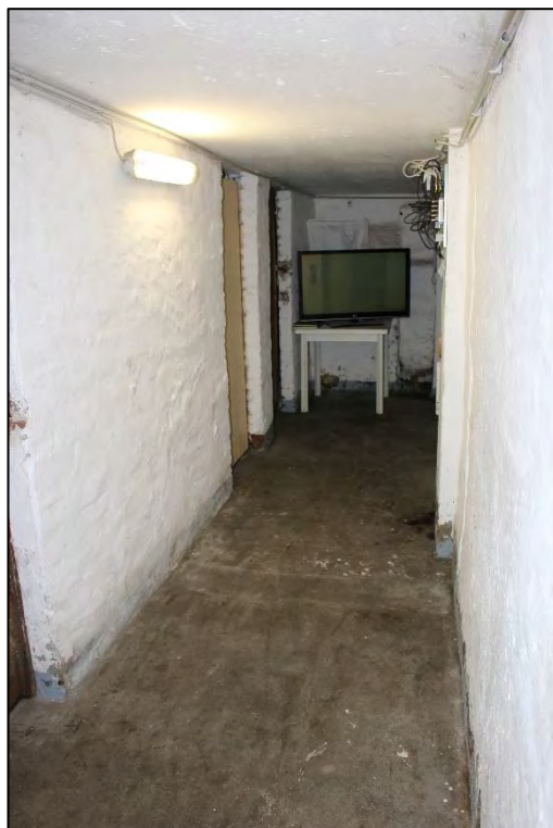
Foto Nr. 12: Dresdener Straße 28, Kellergeschoss, Flur
