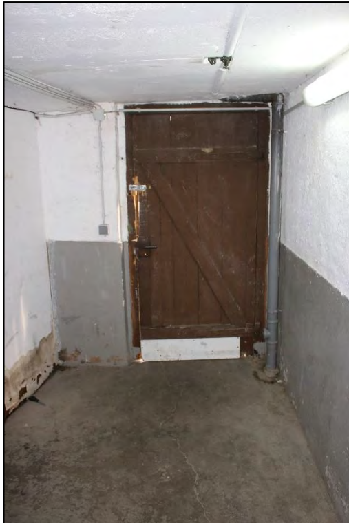
Foto Nr. 13: Dresdenener Straße 28, Kellergeschoss, Kelleraußeneingang
