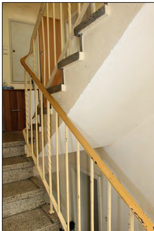
Foto Nr. 38: Dresdener Straße 28, Gemeinschaftstreppe
