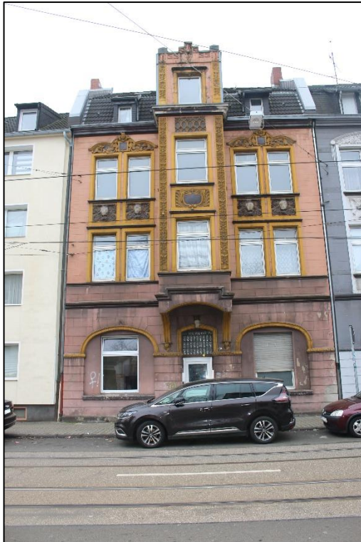
Foto Nr. 1: Straßenfassade
