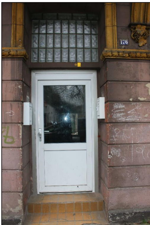
Foto Nr. 2: Hauseingang
