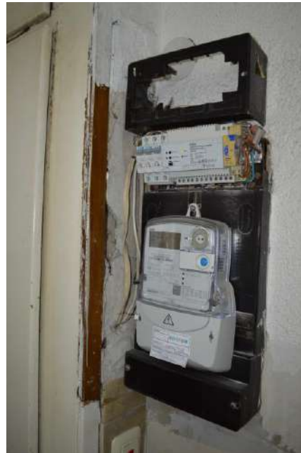
Bild 6: Beispiel Elektrounterverteilung
