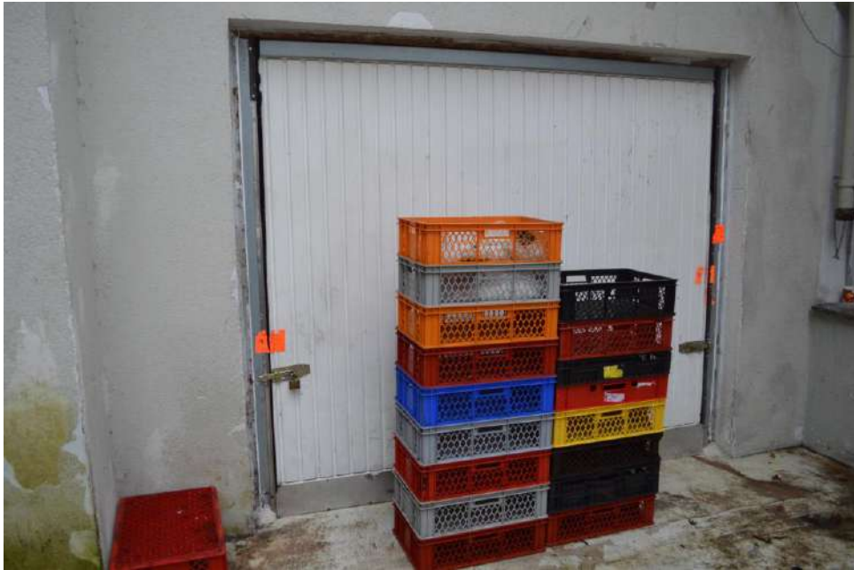
Bild 13: entfernte Versiegelung Hofgebäude
