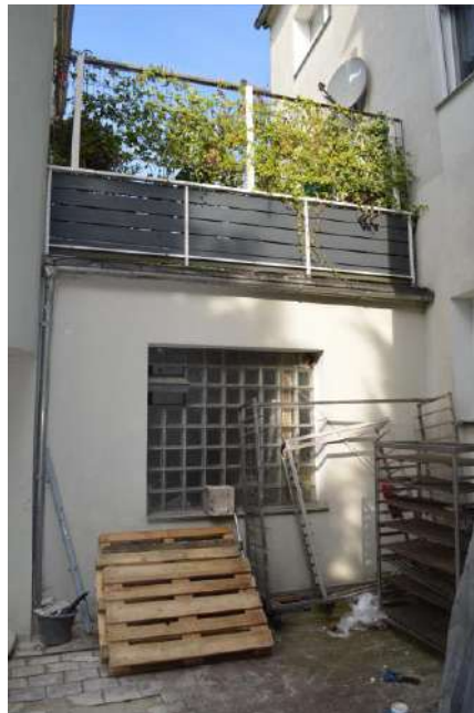
Bild 7: Übergang Mehrfamilienhaus / Hofgebäude
