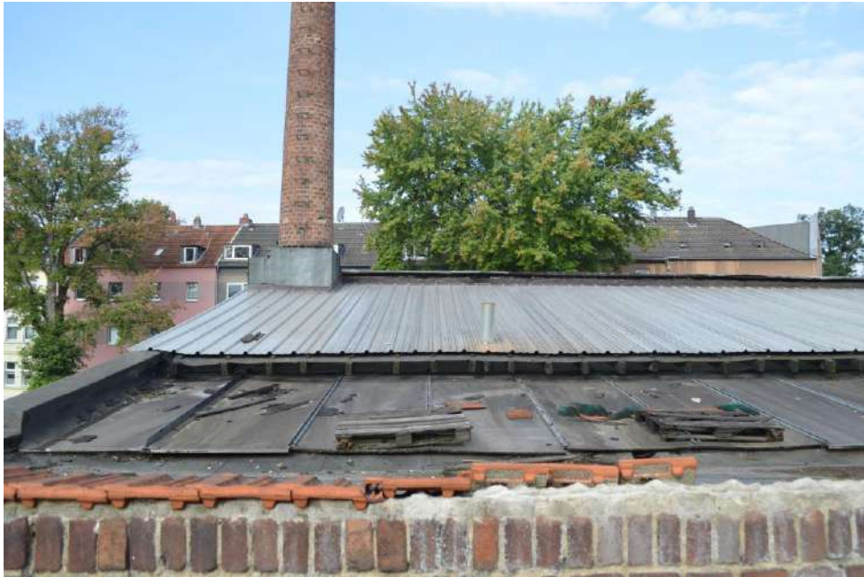
Bild 9: Ansicht Dacheindeckung Hofgebäude
