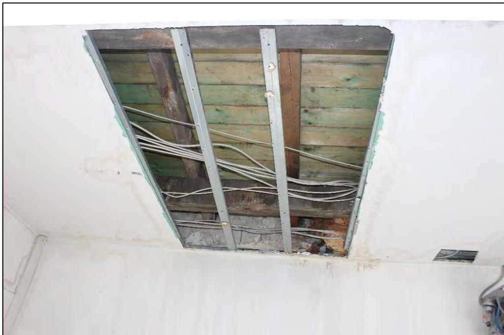
Foto Nr. 58: Werkstattgebäude, Werkstatt Feuchteschäden Decke
