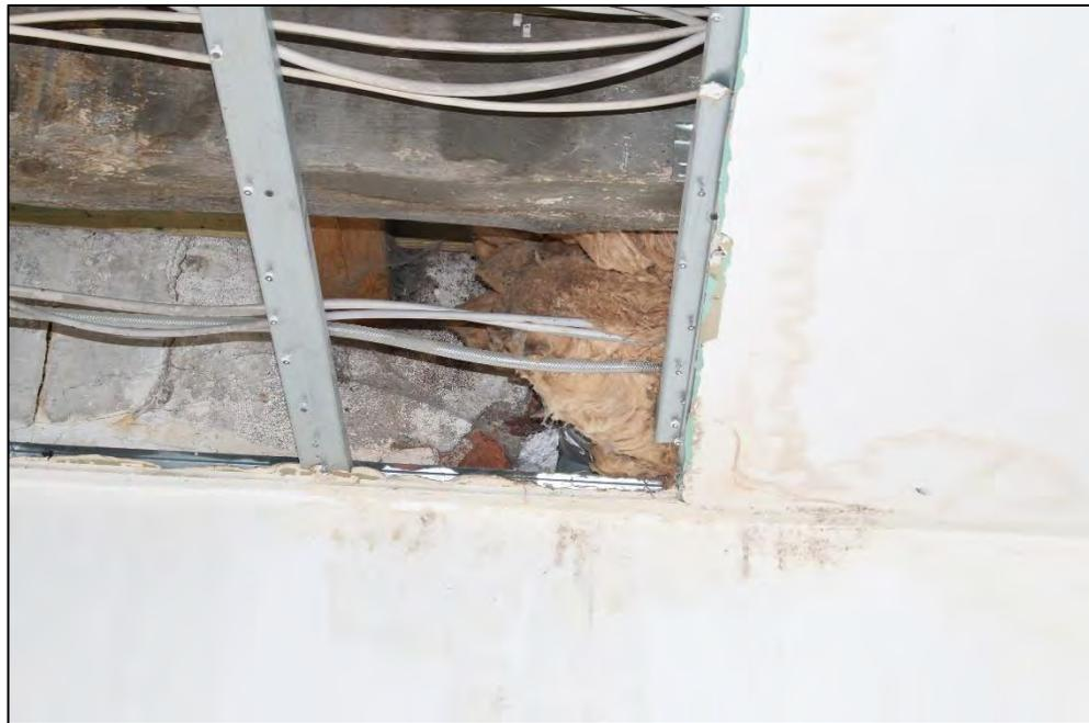
Foto Nr. 59: Werkstattgebäude, Werkstatt, Feuchteschäden Decke
