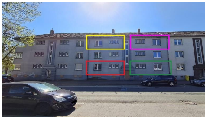
1) Straßenansicht Haus Nr. 127 und 129
