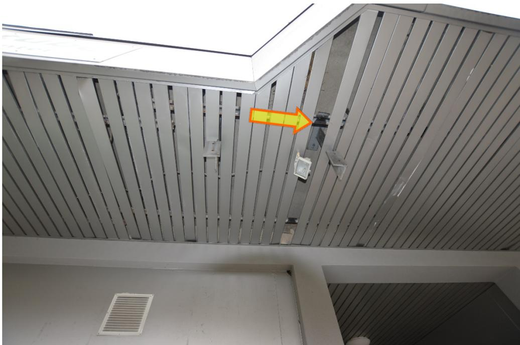
Fehlende Verblendung an der Überdeckung der Eingangs- und Schaufensterbereiche (Beispiel)
