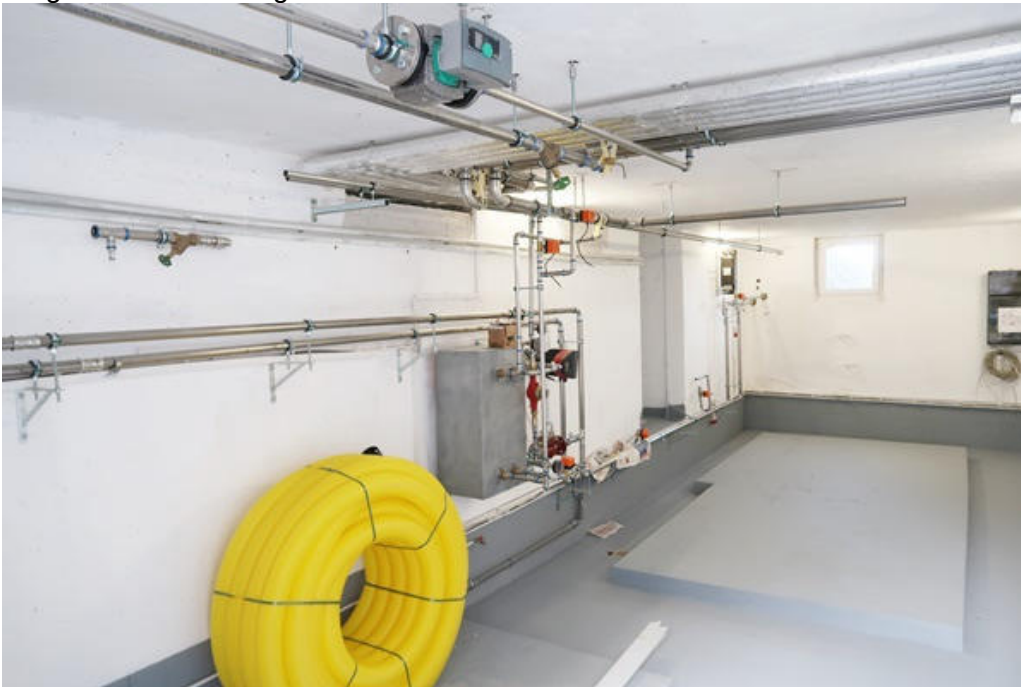
Begonnene Abdichtungsarbeiten an den erdberührten Außenwänden
