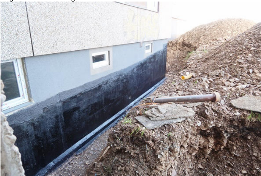
Begonnene Abdichtungsarbeiten an den erdberührten Außenwänden
