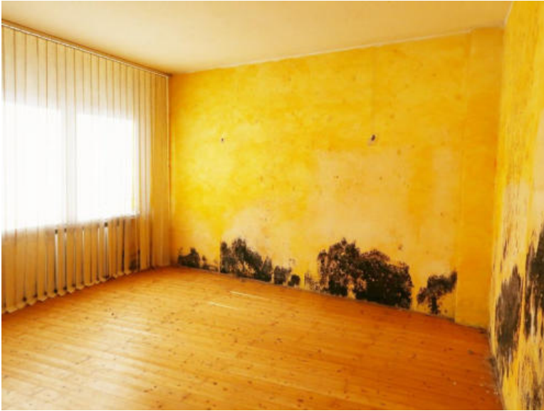
Schimmelauswüchse im Büro im OG
