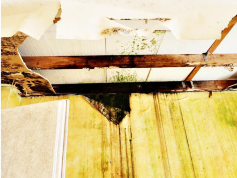
Detailaufnahme Deckenbereich im Büro Obergeschoß
