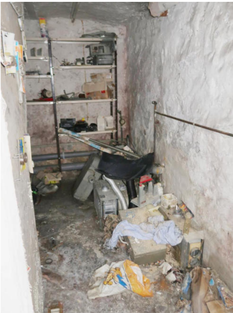
Kellerbereich mit Räumungsbedarf
